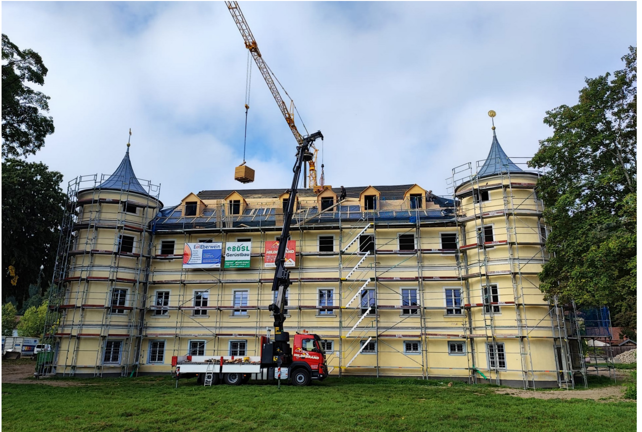
Aktuelles Bild des Baufortschrittes: 20.09.2023
