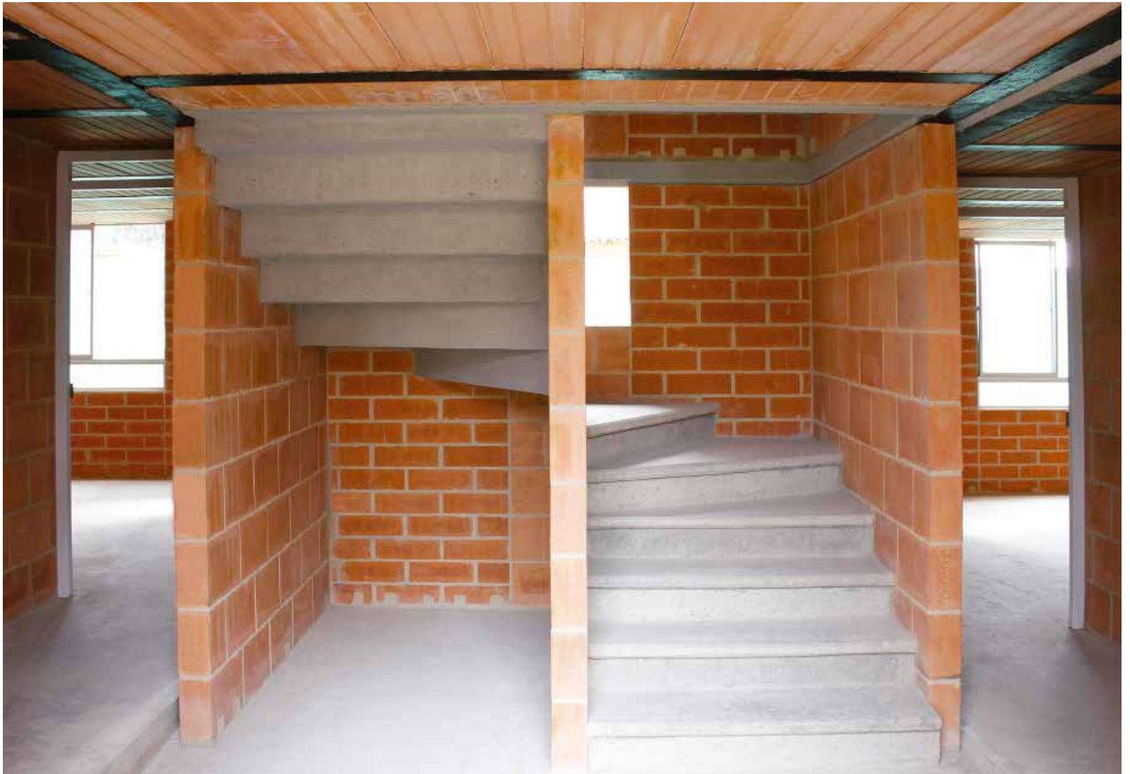
Sistema apoyado en muros estructurales
