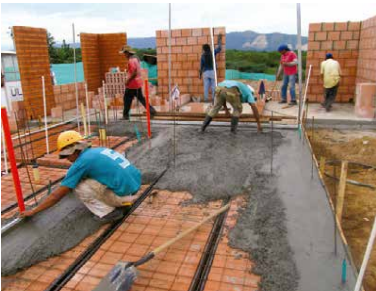
Colocación de concreto
