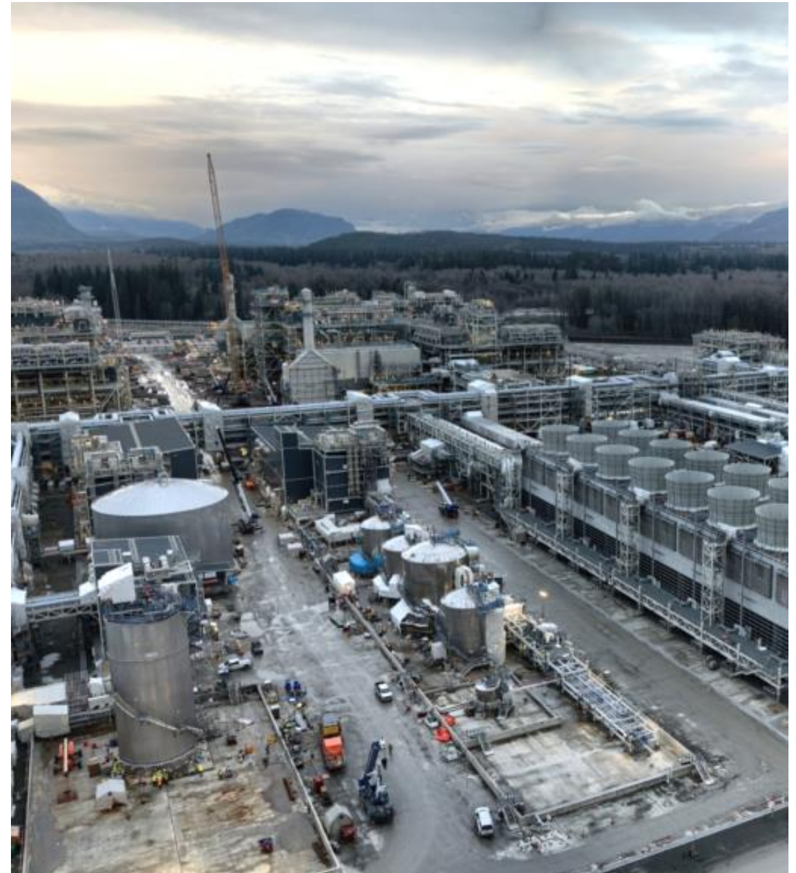
Source: LNG Canada
