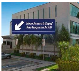
Novo acesso à sede da Capef
