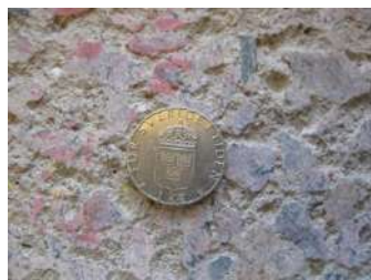
Figur 5-7 Avskalning orsakad av saltfrostangrepp (Lindegård & Markungar, 2014)
