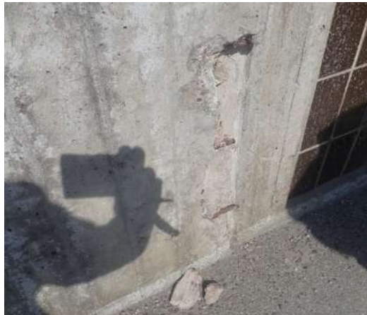
Figur 5-5 Spjälkning av stödmur (Ansnaes, 2019)
