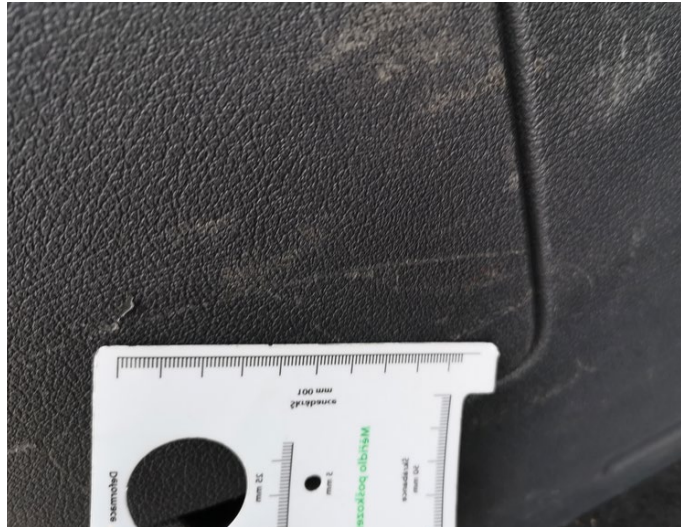
LCV - IX.VI. - Unacceptable
