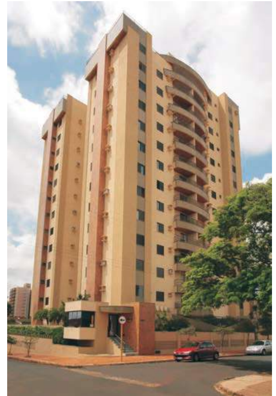
Edifício Astúrias Jaboticabal/SP
