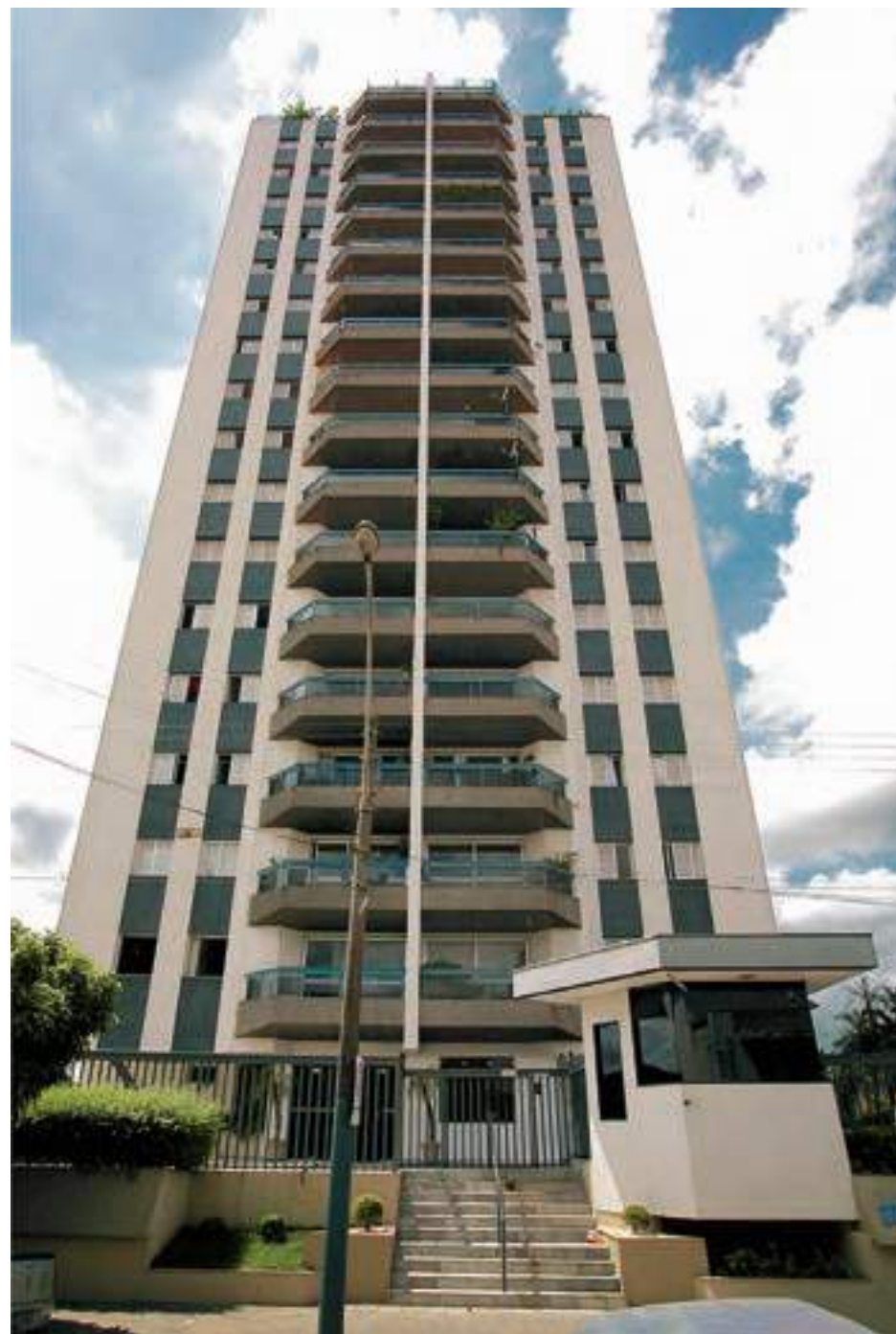
Edifício Ilha Bela Jaboticabal/SP
