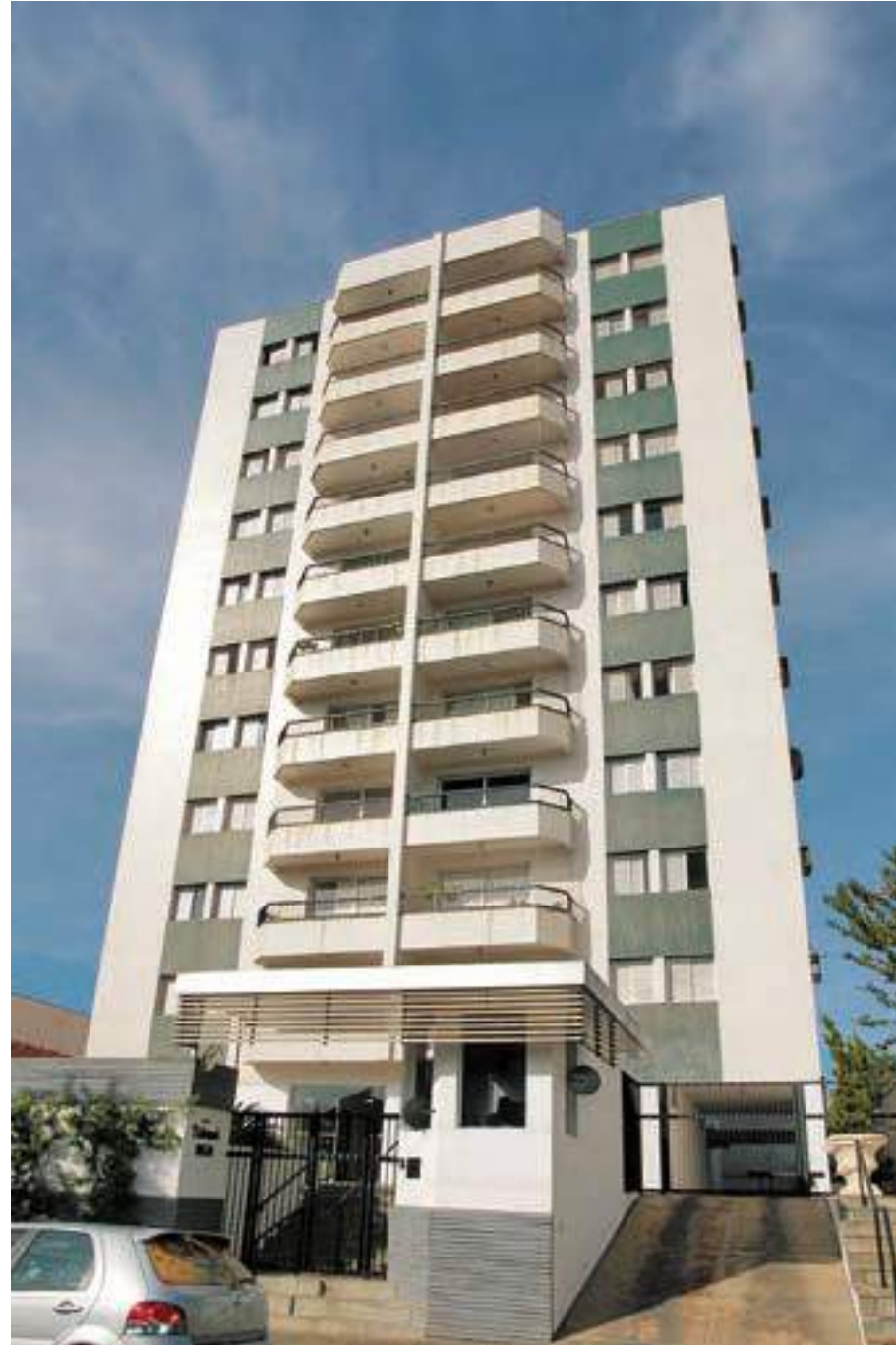
Edifício Tabapuã Jaboticabal/SP
