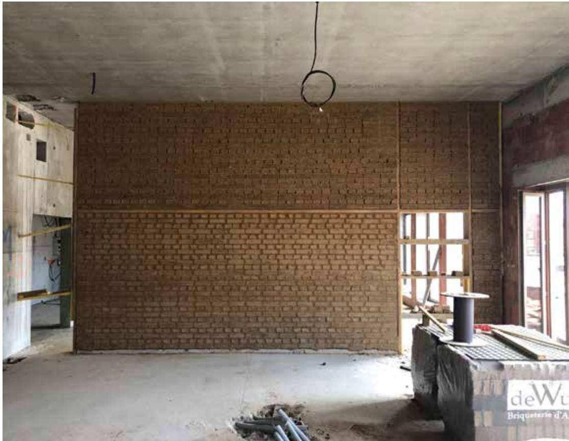
Joly&Loiret architectes, photo Paul-Emmanuel Loiret Mur en Briques de terre crue extrudée en cours de réalisation
