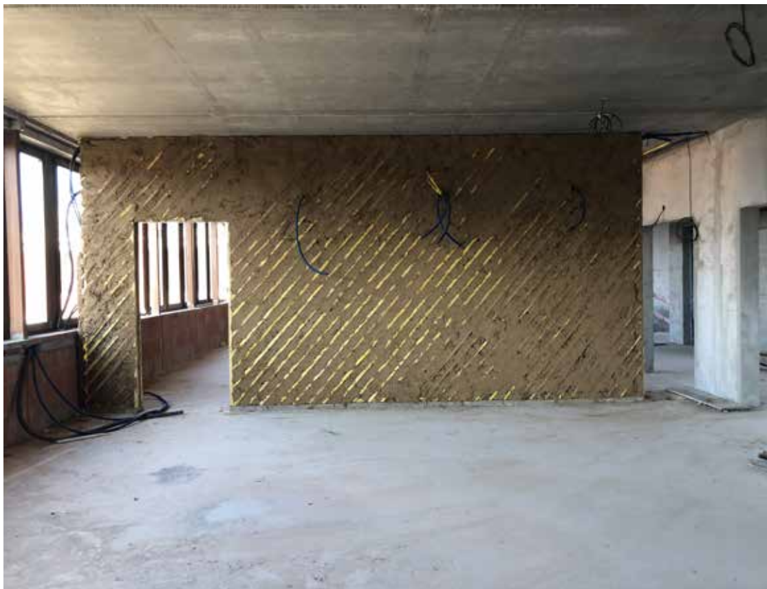
Joly&Loiret architectes, photo Paul-Emmanuel Loiret Mur en torchis en cours de réalisation
