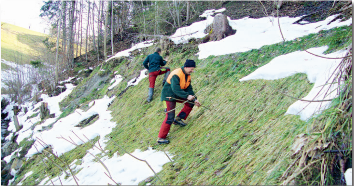
Am Mitteldorfbach werden Weidenstecklinge eingebracht, die mit ihren Wurzeln die Böschung stabilisieren.
