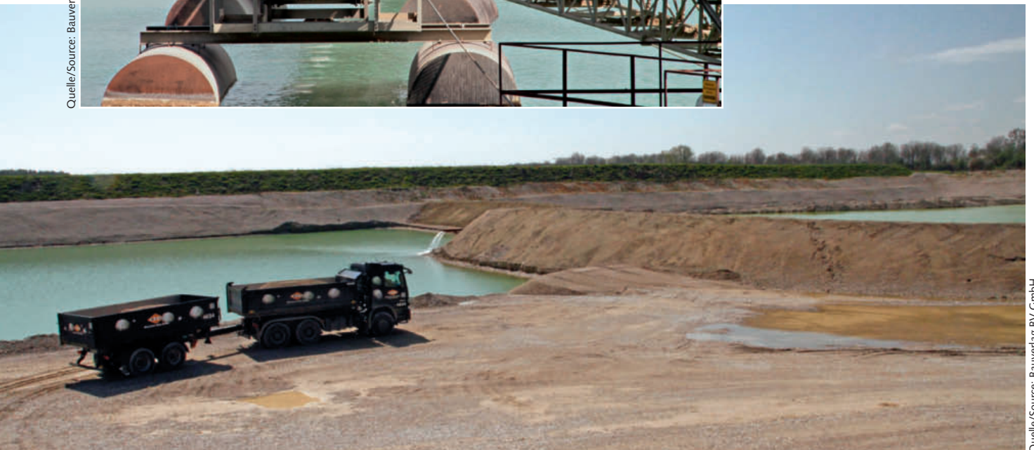
6 Wasserbecken für die Frischwasserversorgung (rechts) • Water basin for the supply of fresh water (right)
