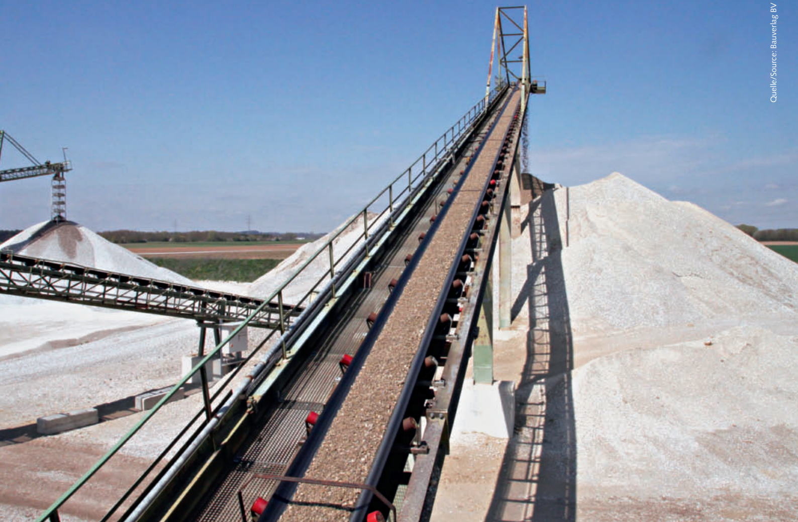
9 Beschickung der Vorratshalde • Supply to the stockpile
