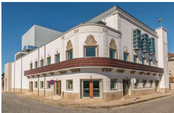
Fachada do Cineteatro
