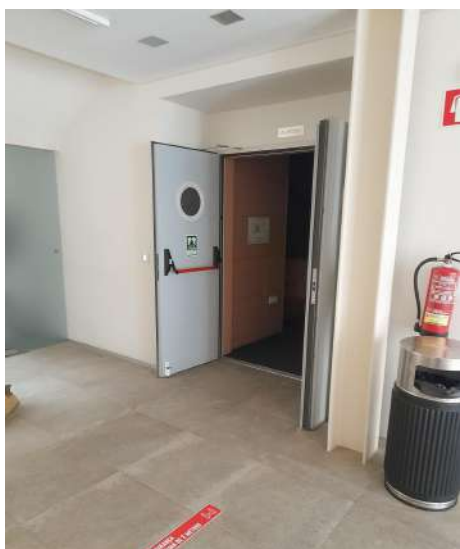
Porta de acesso ao Auditório Principal
