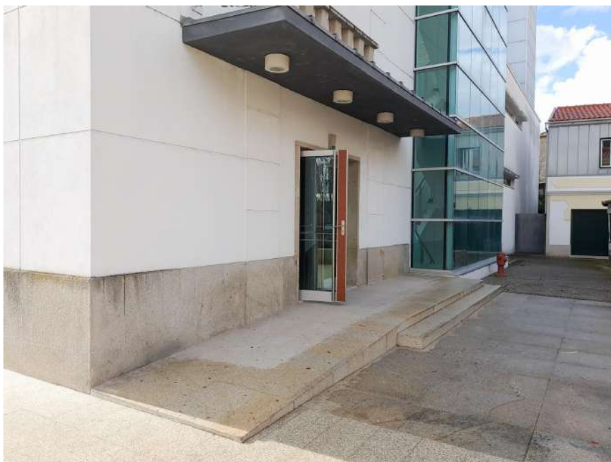
Rampa de acesso para pessoas com mobilidade reduzida
