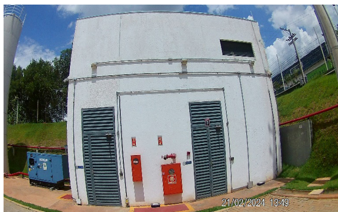
Casa de Máquinas
