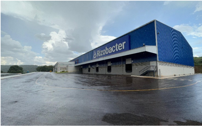
Docas do Galpão
