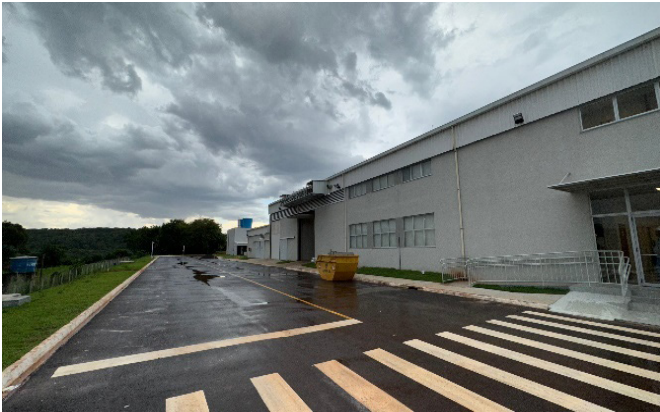
Circulação do Galpão
