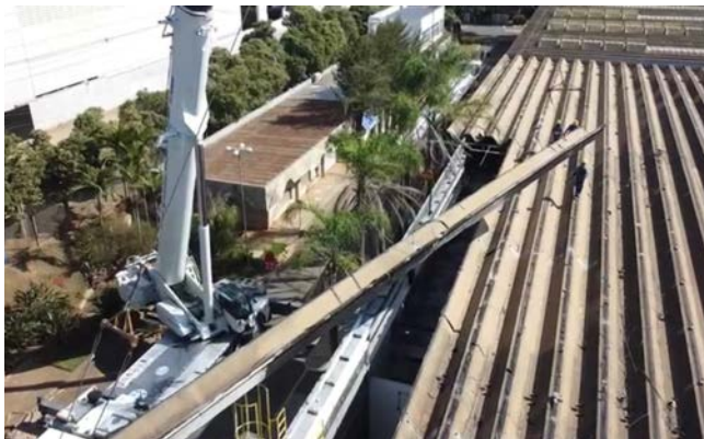
Telhado do Galpão de Tecelagem I - Durante das Obras
