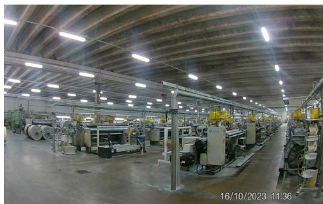
Iluminação do Galpão de Tecelagem I - Depois das Obras
