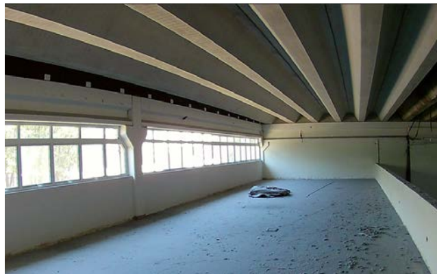
Telhado do Galpão de Tecelagem I - Depois das Obras
