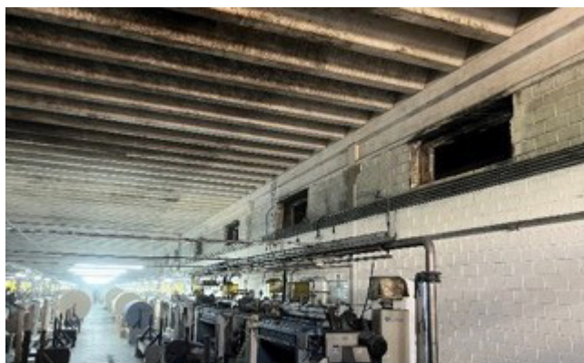
Galpão de Tecelagem I - Antes das Obras
