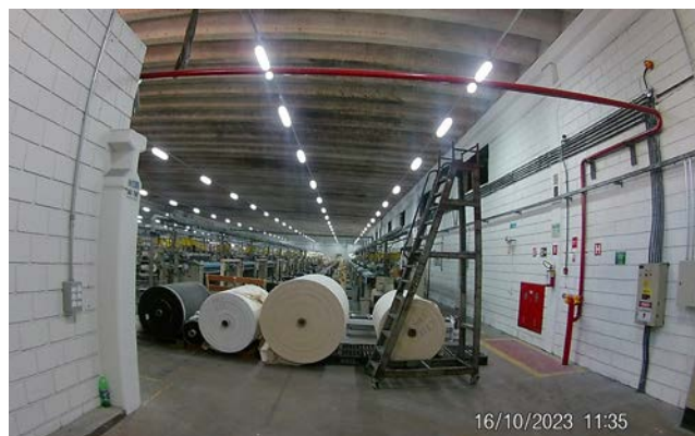
Galpão de Tecelagem I - Depois das Obras
