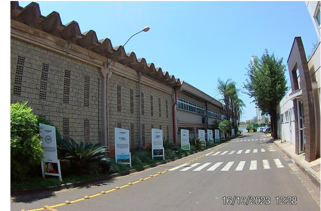
Fachada lateral do galpão
