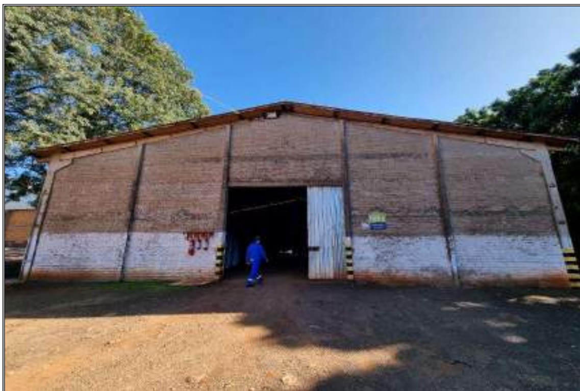
VISTA GERAL DO GALPÃO
