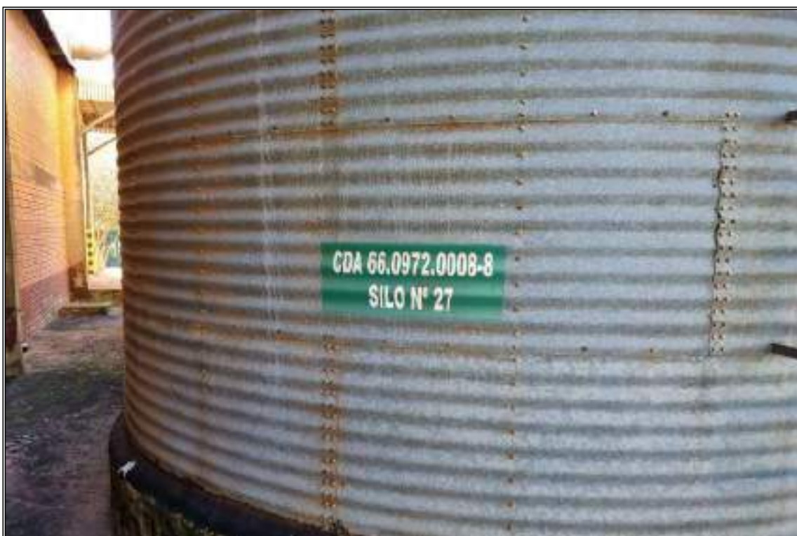
ITEM 2,009 - VISTA DA PLACA DE IDENTIFICAÇÃO DO SILO DE ARMAZEMAGEM METÁLICO CAP: 90 TON COM VENTILADOR CENTRÍFUGO Nº 27
