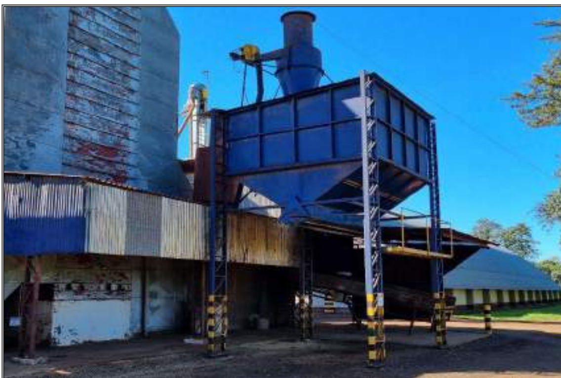
ITEM 1,021 - VISTA DA TULHA METÁLICA PARA EXPEDIÇÃO DE RESÍDUOS
