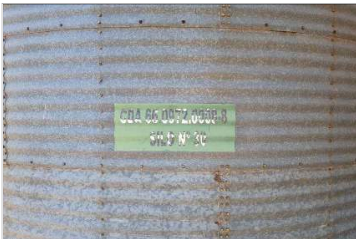
ITEM 2,012 - VISTA DA PLACA DE IDENTIFICAÇÃO DO SILO DE ARMAZEMAGEM METÁLICO CAP: 90 TON COM VENTILADOR CENTRÍFUGO Nº 30
