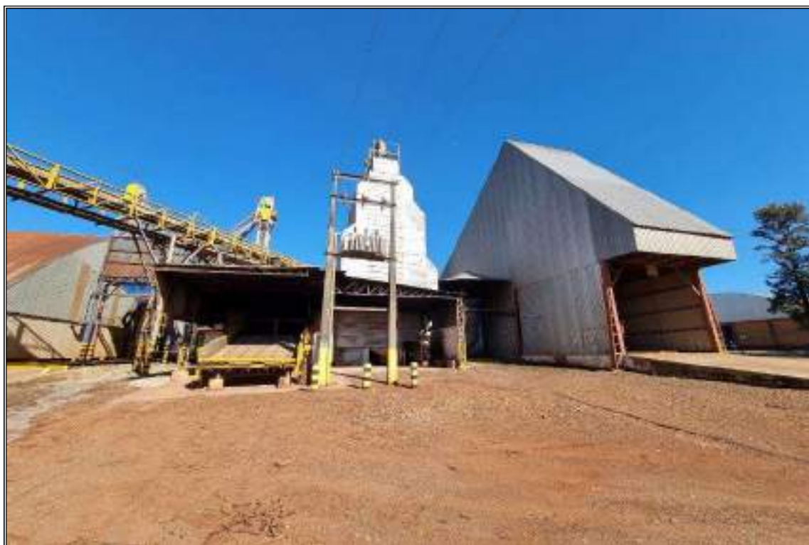
VISTA PARCIAL EXTERNA
