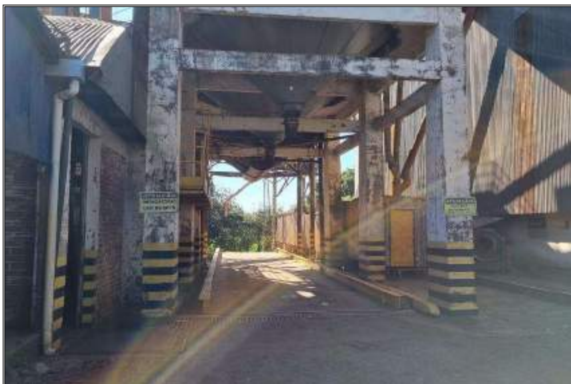
ITEM 1,023 - VISTA DA BALANÇA RODOVIÁRIA MARCA: SATURNO COMPRIMENTO: 25 M CAP: 100 TON
