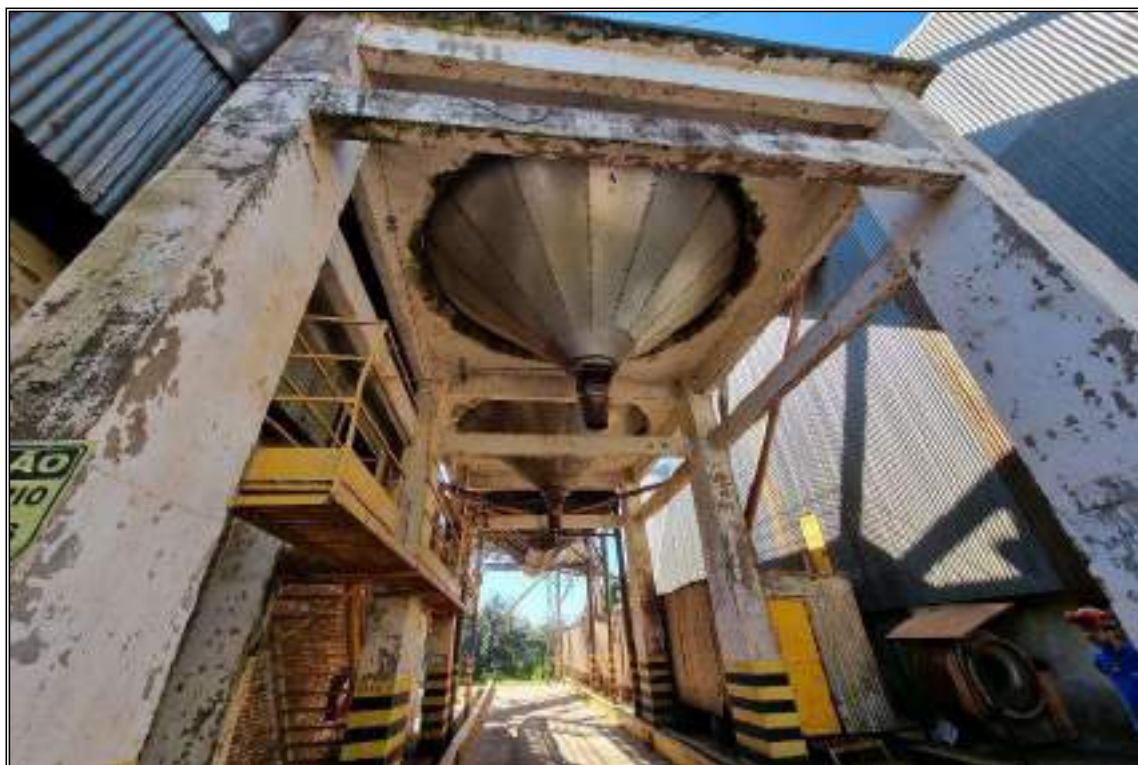
ITEM 1,024 - VISTA DO SILO DE EXPEDIÇÃO
