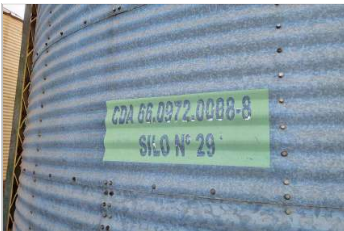
ITEM 2,011 - VISTA DA PLACA DE IDENTIFICAÇÃO DO SILO DE ARMAZEMAGEM METÁLICO CAP: 90 TON COM VENTILADOR CENTRÍFUGO Nº 29
