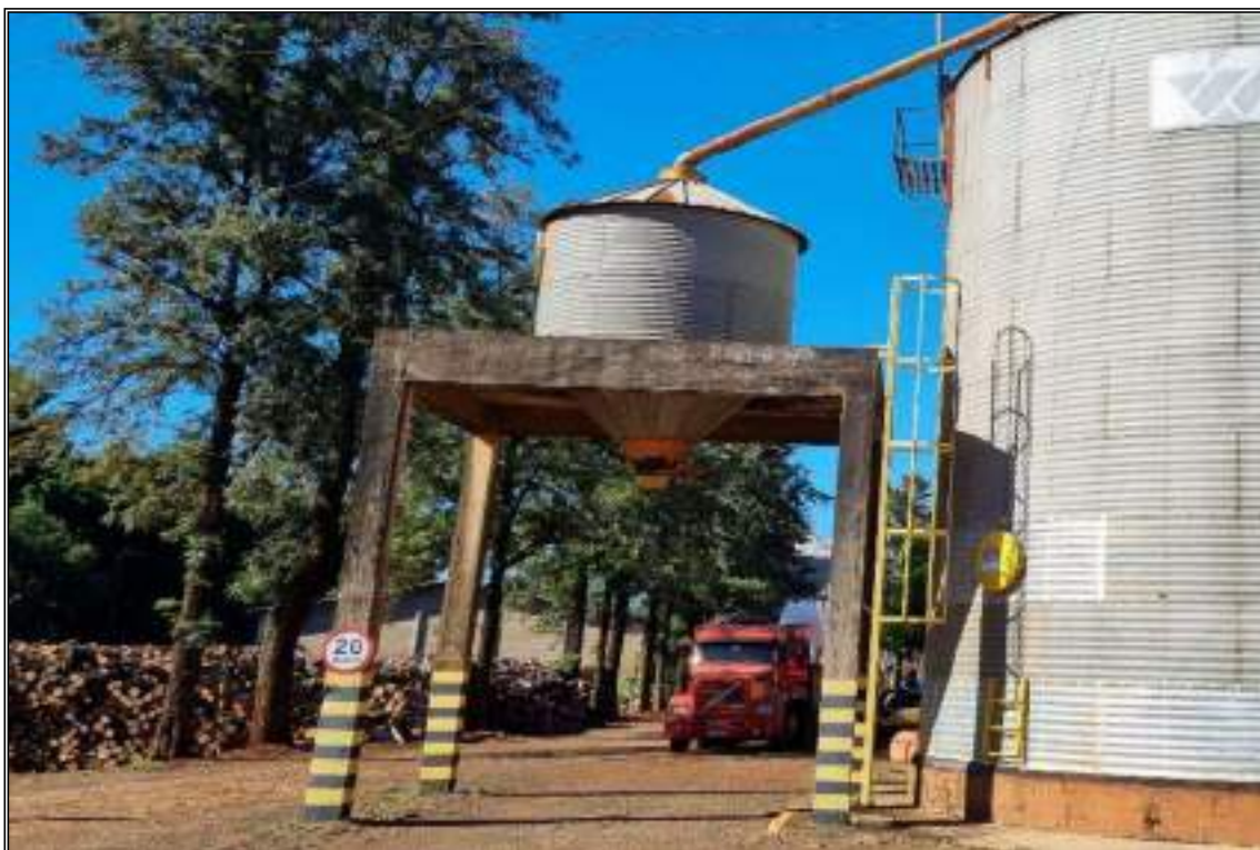
ITEM 2,016 - VISTA DO SILO DE EXPEDIÇÃO ELEVADO METÁLICO
