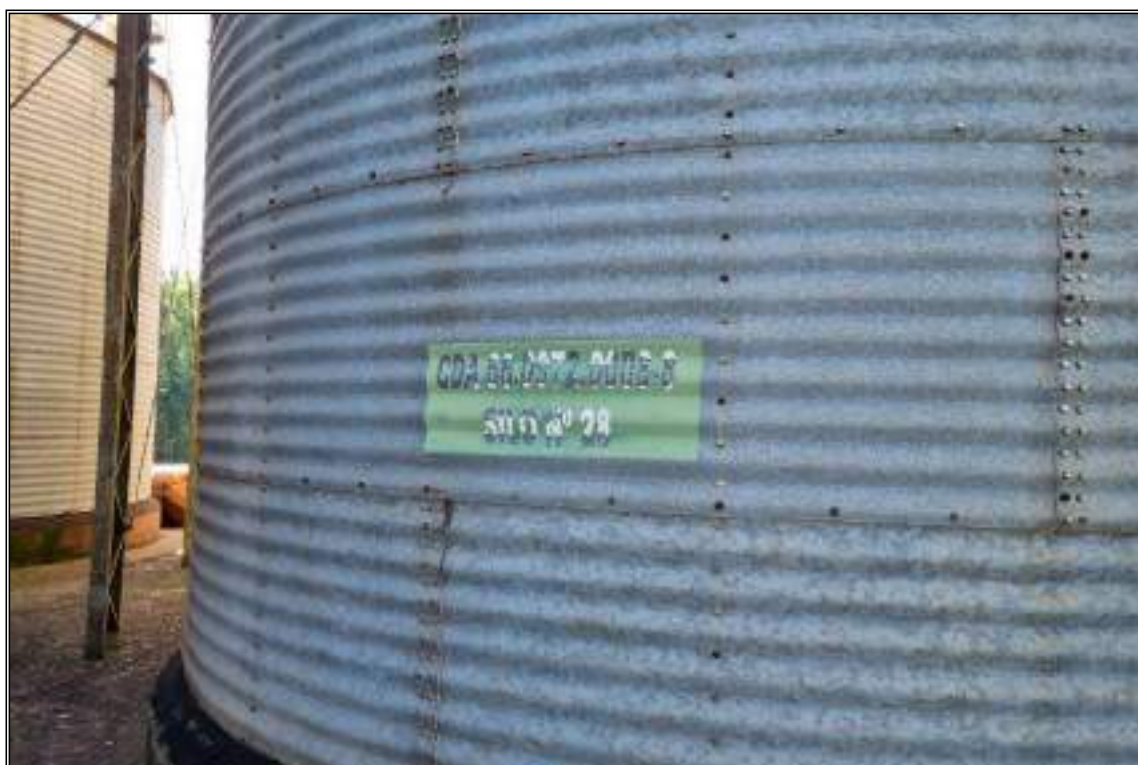
ITEM 2,010 - VISTA DA PLACA DE IDENTIFICAÇÃO DO SILO DE ARMAZEMAGEM METÁLICO CAP: 90 TON COM VENTILADOR CENTRÍFUGO Nº 28
