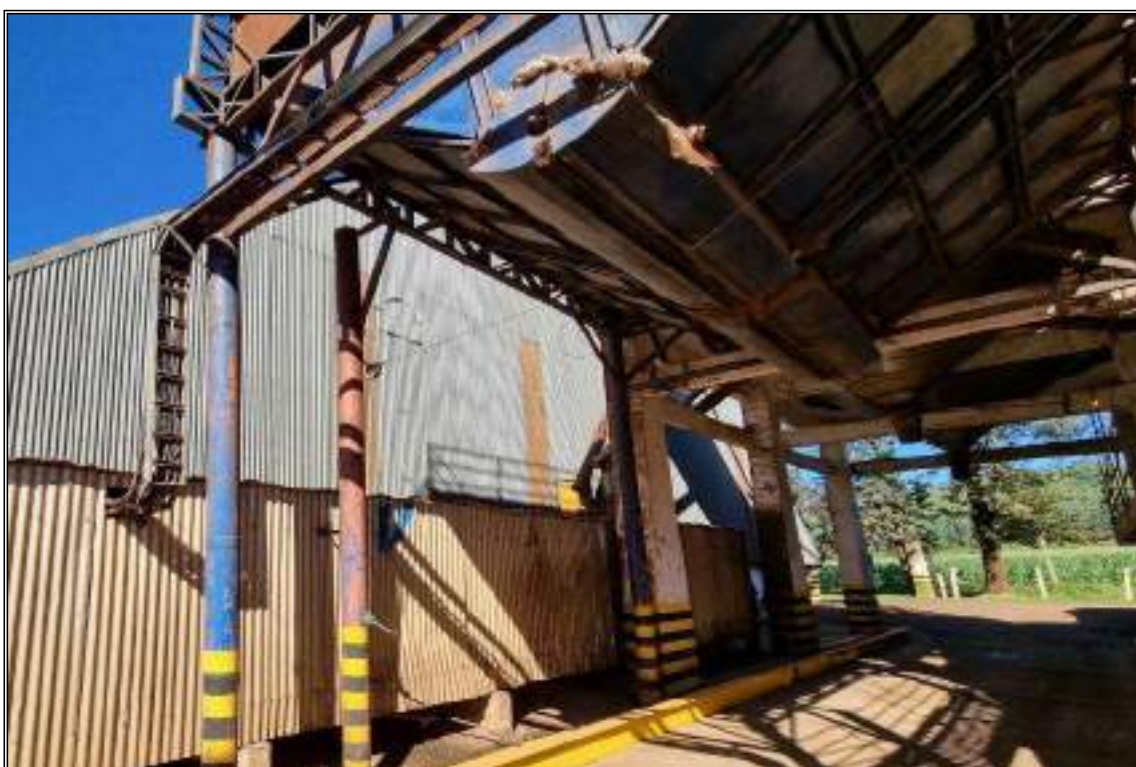
ITEM 1,026 - VISTA DA TULHA METÁLICA PARA EXPEDIÇÃO DE RESÍDUOS
