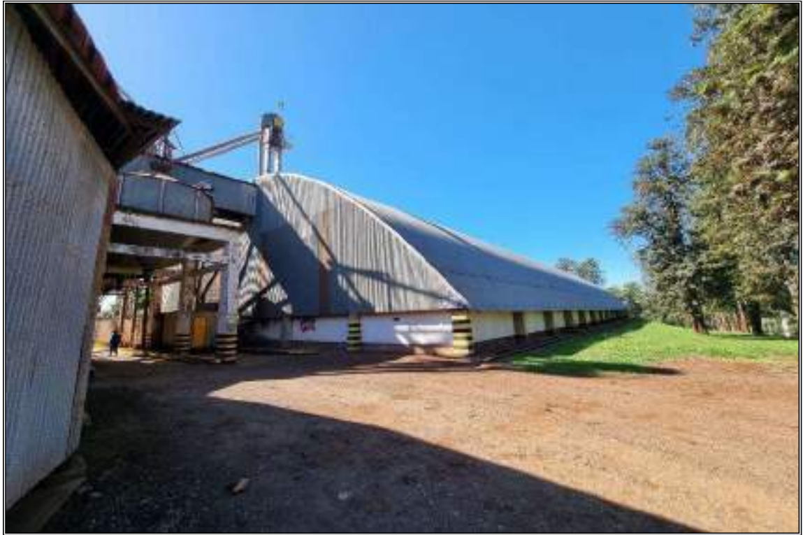
VISTA PARCIAL EXTERNA
