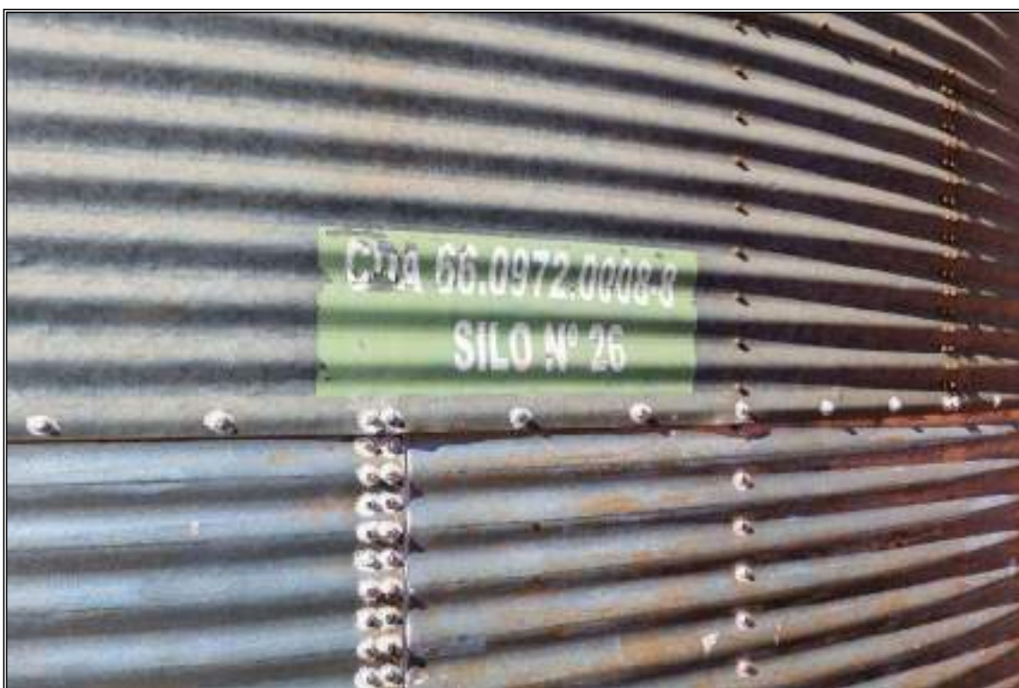
ITEM 2,015 - VISTA DO SILO DE ARMAZENAGEM METÁLICO CAP: 600 TON Nº 26
