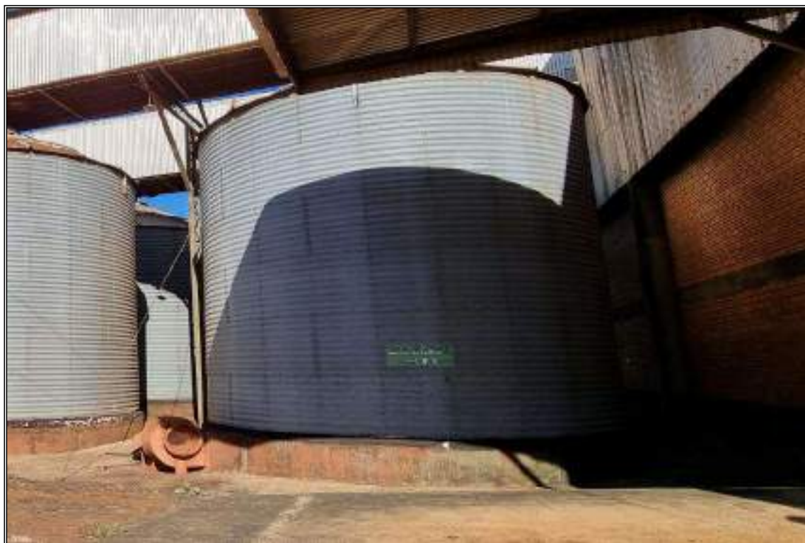
ITEM 2,012 - VISTA DO SILO DE ARMAZEMAGEM METÁLICO CAP: 90 TON COM VENTILADOR CENTRÍFUGO Nº 30
