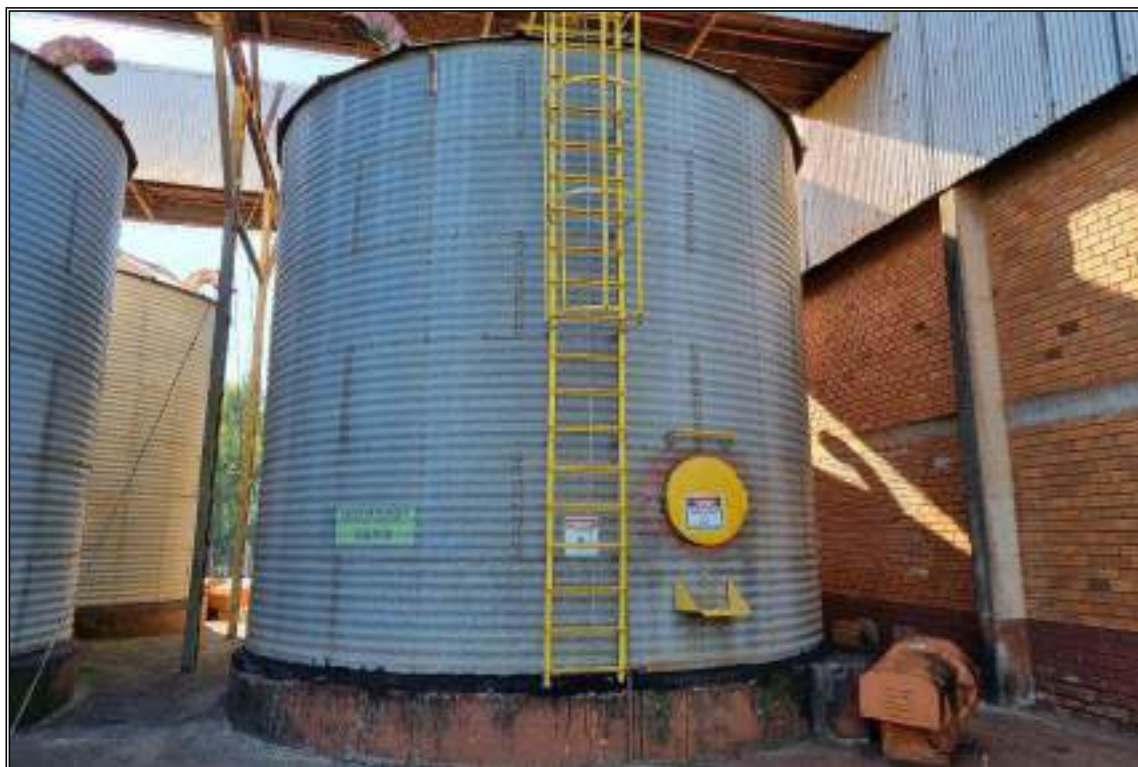
ITEM 2,011 - VISTA DO SILO DE ARMAZEMAGEM METÁLICO CAP: 90 TON COM VENTILADOR CENTRÍFUGO Nº 29
