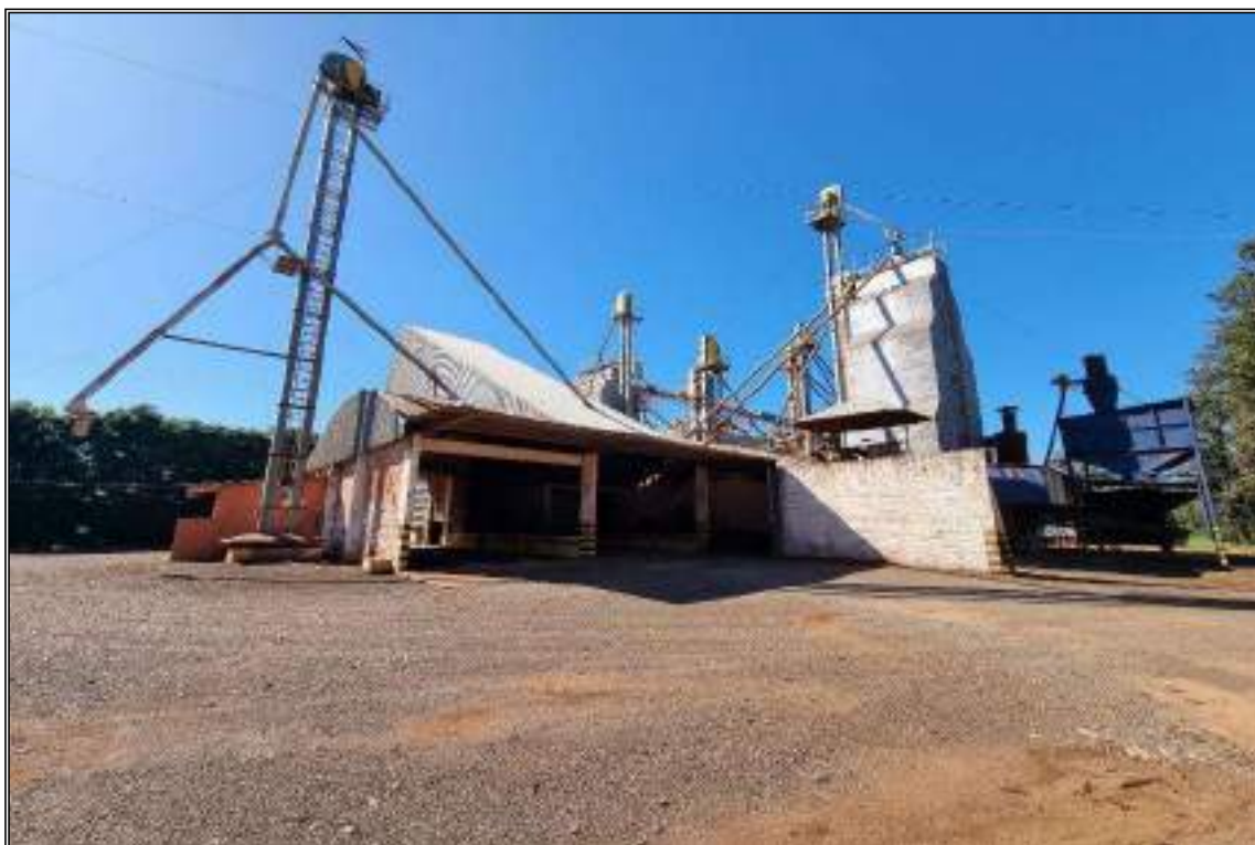
ITEM 1,001 - VISTA DA UNIDADE ARMazenadora DE GRÃOS CAP: 30.000 TON COMPREENDENDO OS EQUIPAMENTOS RELACIONADOS NOS ITENS 1,003 A 1,035
