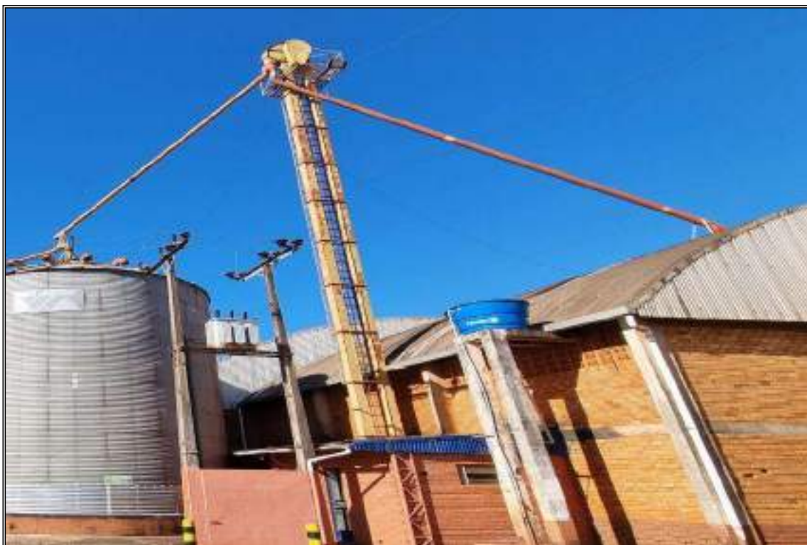
ITEM 2,018 - VISTA DO ELEVADOR DE CANECAS PLÁSTICA PARA CAPTAÇÃO DE GRÃOS DA MÁQUINA DE PRÉ-LIMPEZA PARA CORREIA TRANSPORTADORA E SILO DE EXPEDIÇÃO
