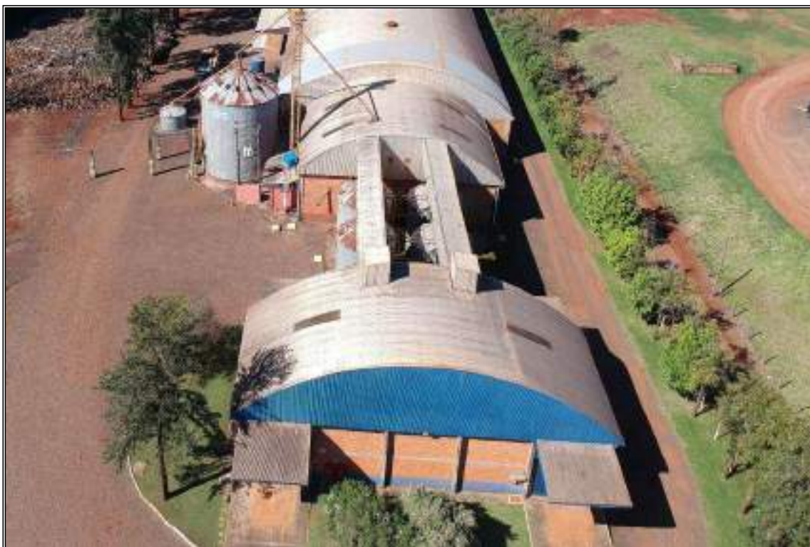
ITEM 2,001 - VISTA DA UNIDADE ARMAZENADORA DE GRÃOS CAP: 870 TON COMPREENDENDO OS EQUIPAMENTOS RELACIONADOS NOS ITENS 2,002 A 2,018
