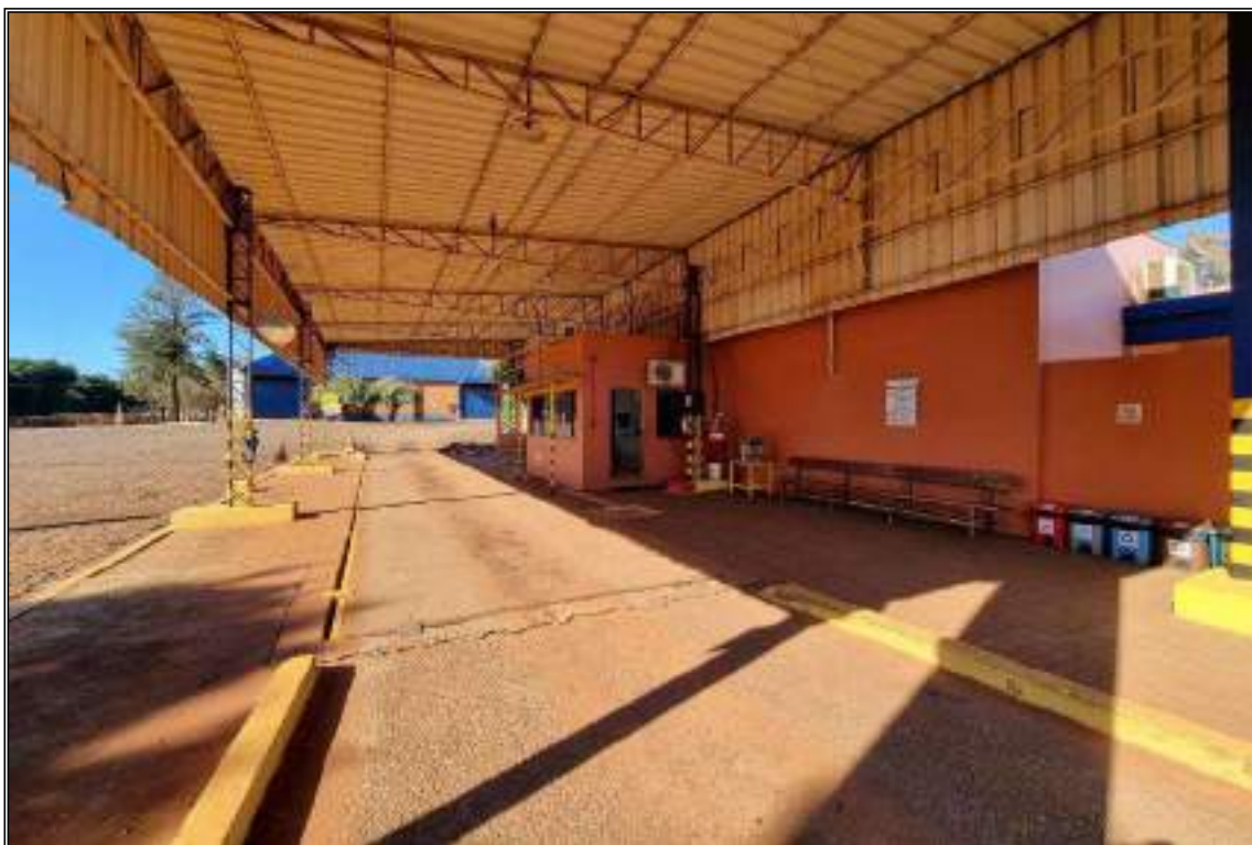
ITEM 1,002 - VISTA DA BALANÇA RODOVIÁRIA COMPRIMENTO: 18 M CAP: 80 TON
