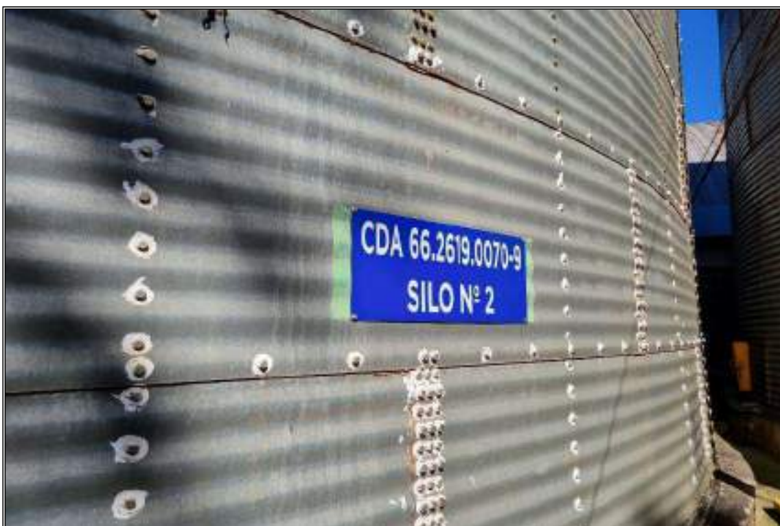
ITEM 1,034 - VISTA DA PLACA DE IDENTIFICAÇÃO DO SILO DE ARMAZEMAGEM METÁLICO Nº 2
