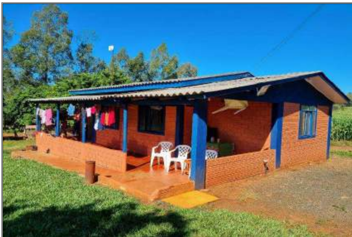
VISTA PARCIAL EXTERNA
