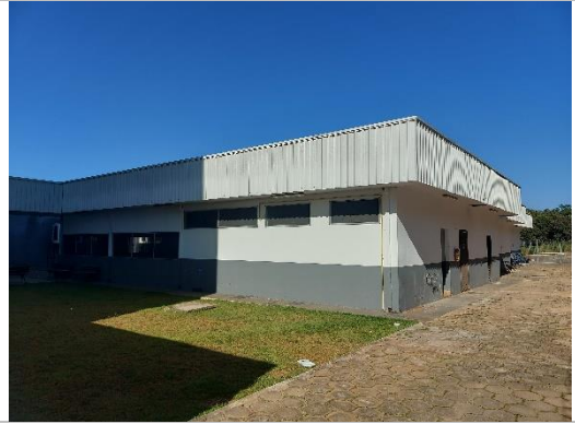
Vista Exterior do Refeitório
