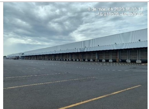
Estacionamento de caminhões
