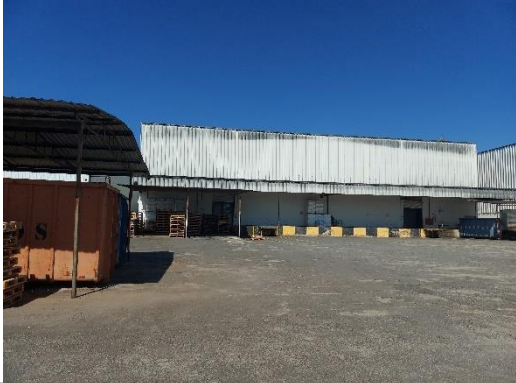
Área de carga e descarga
