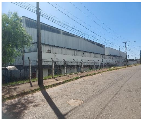
Rua sem nome (Avaliando à direita)
