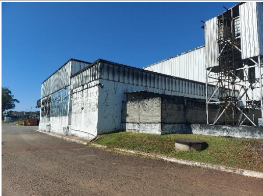
Exterior do galpão
