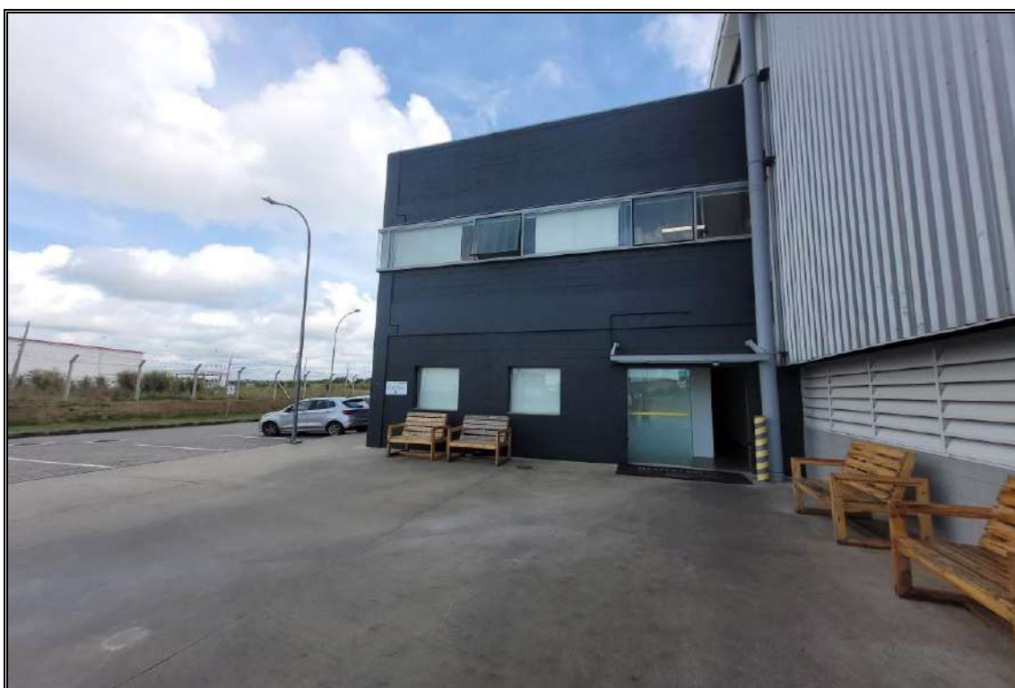
VISTA EXTERNA MARQUISE
