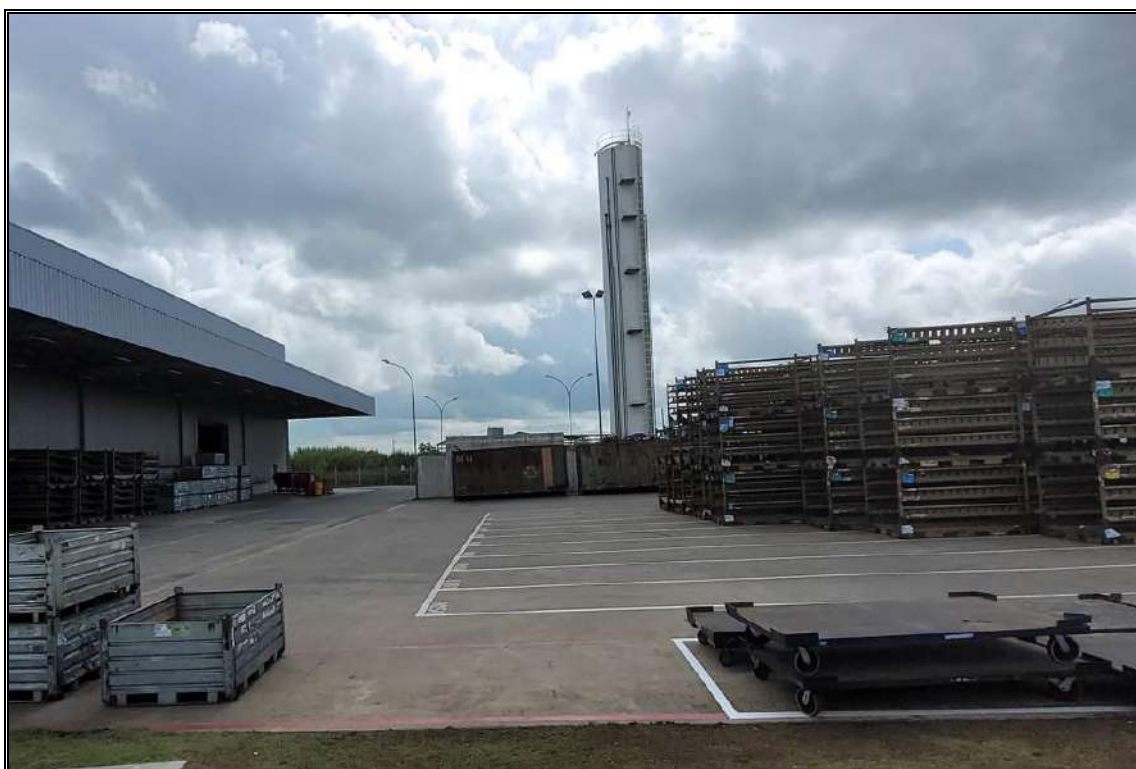
PAVIMENTAÇÃO EM CONCRETO
