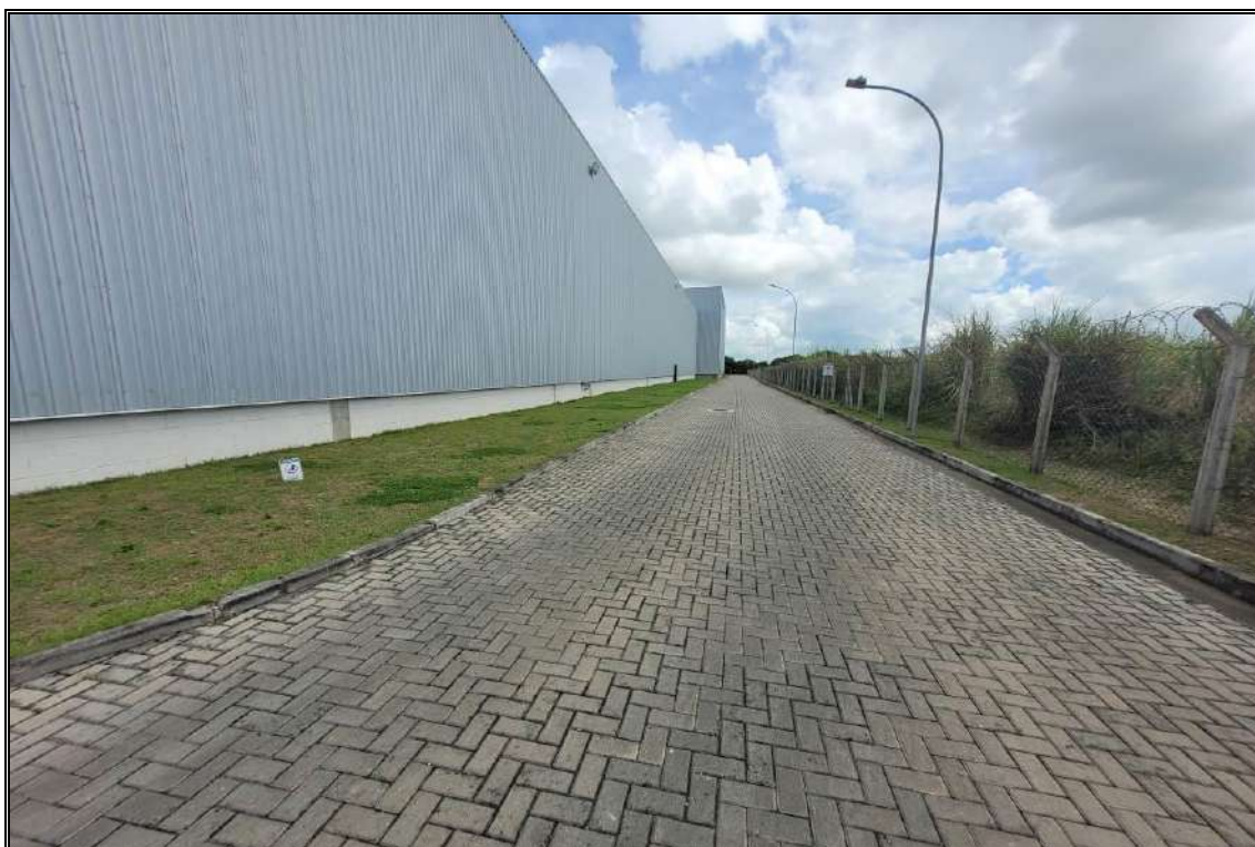
PAVIMENTAÇÃO EM BLOKRET
