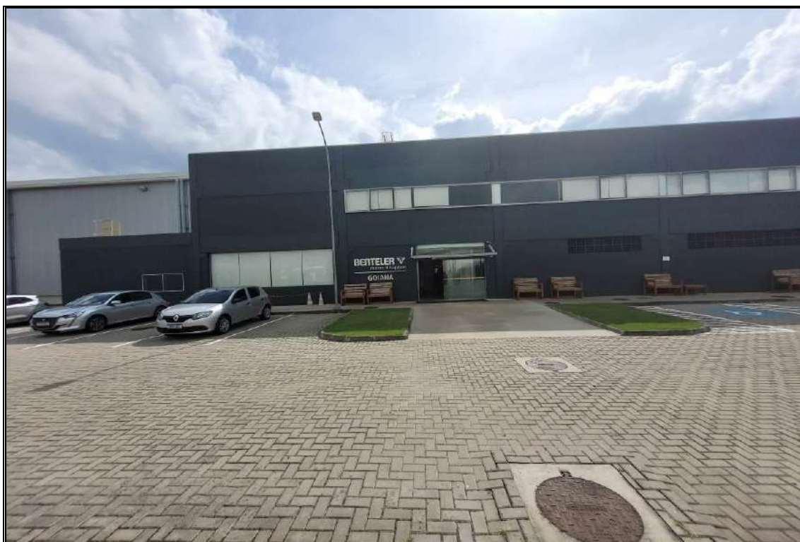
VISTA EXTERNA MARQUISE
