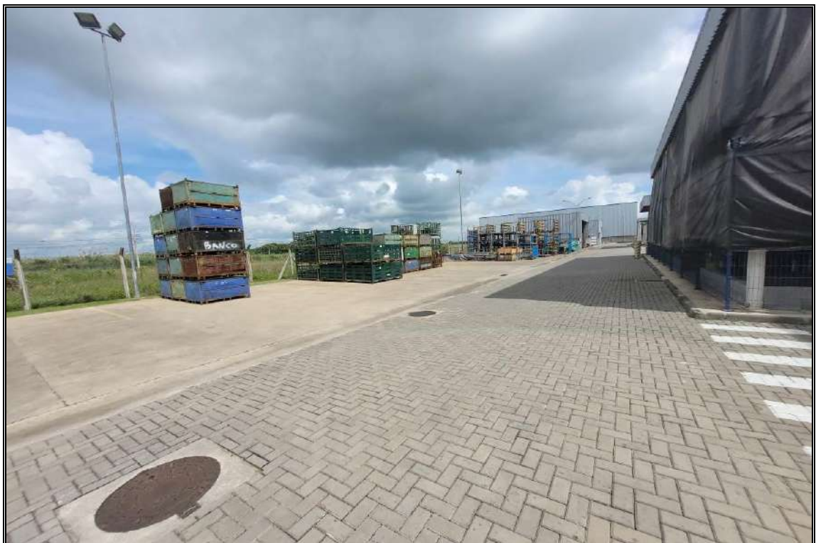
VISTA GERAIS DAS EDIFICAÇÕES COMPLEMENTARES
