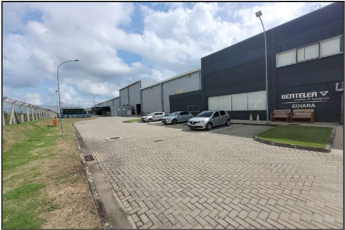
VISTA GERAIS DAS EDIFICAÇÕES COMPLEMENTARES
