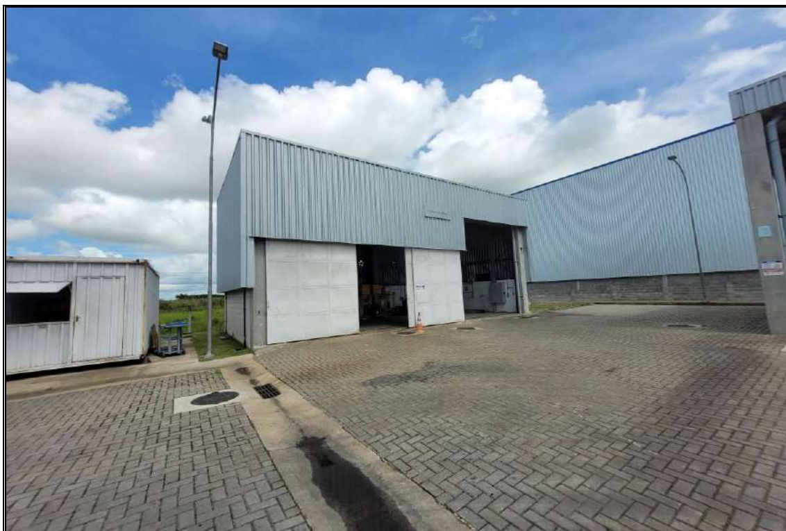
CENTRAL DE BATERIAS
