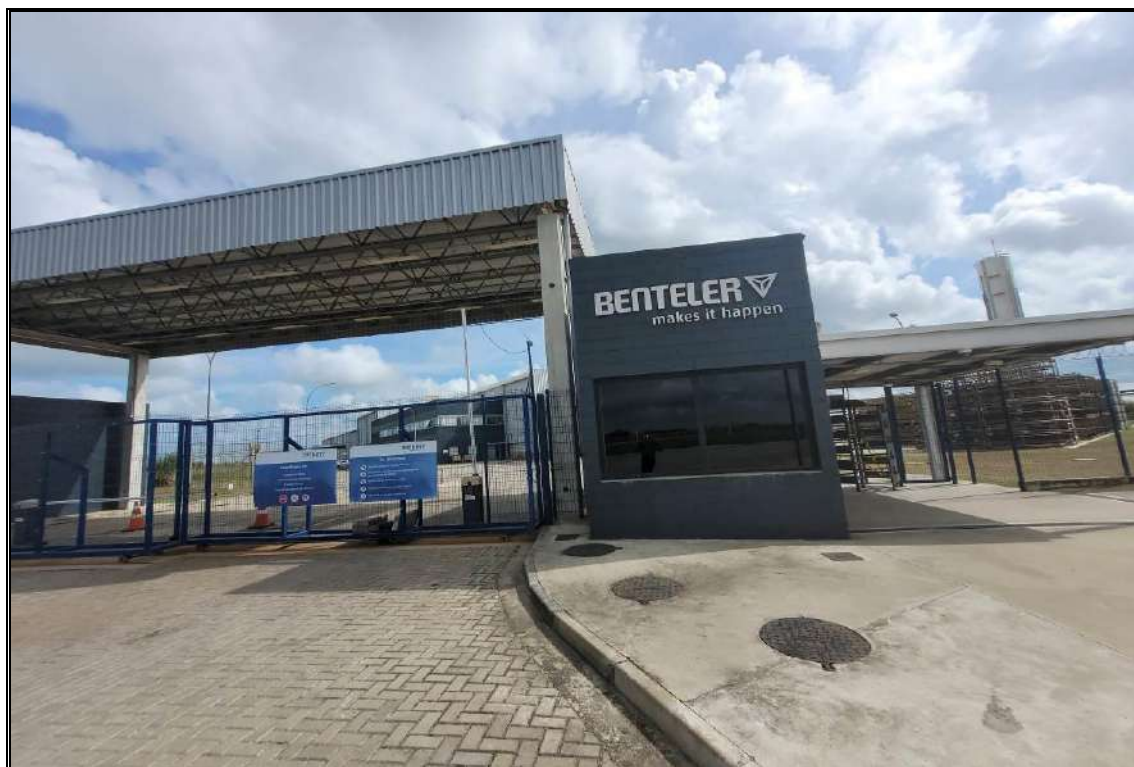
VISTA GERAL DA PORTARIA
