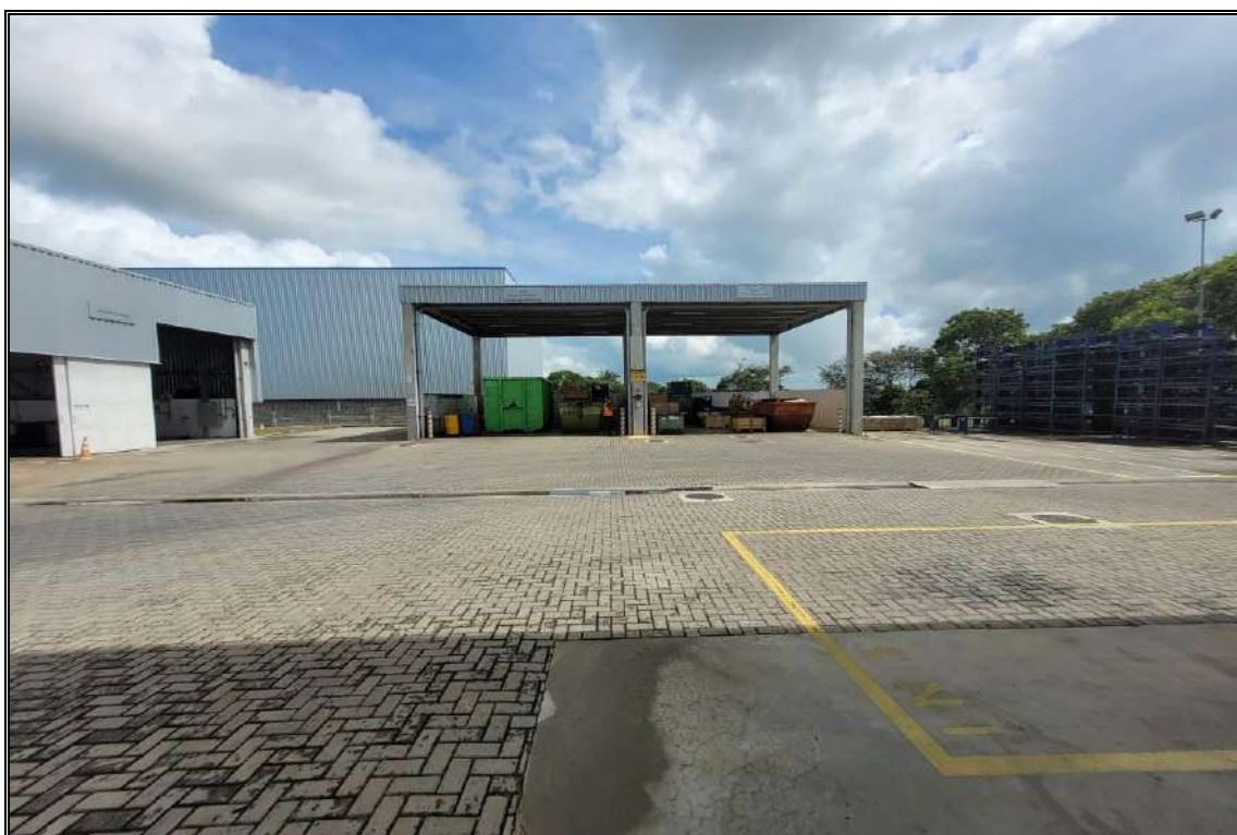
CENTRAL DE RESÍDUOS
