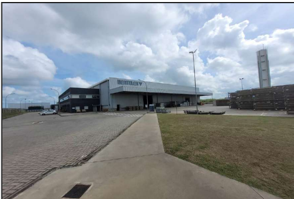
VISTA DO GALPÃO
