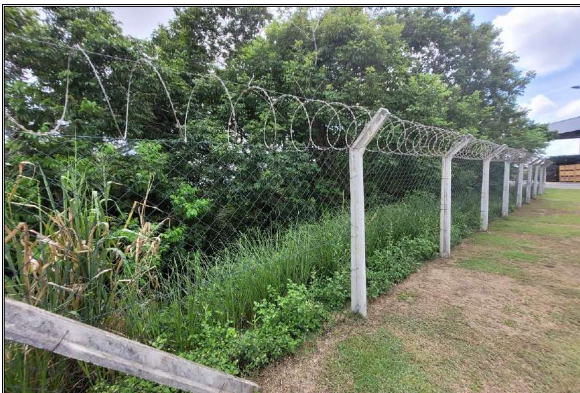
FECHAMENTO LATERAL EM ALAMBRADO
