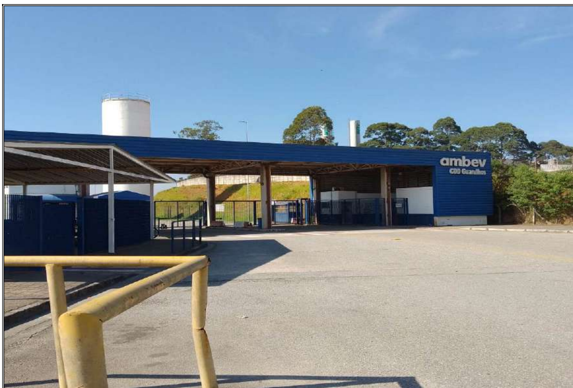
PORTARIA – VISTA EXTERNA
