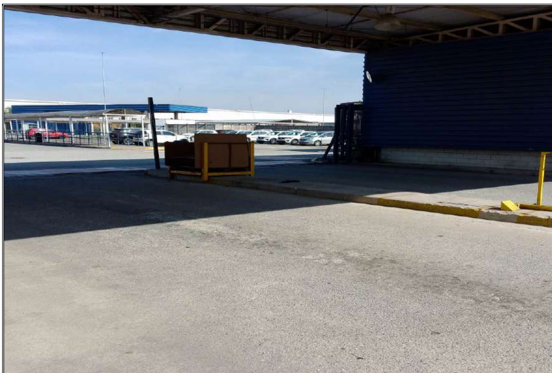
PRÉ-PORTARIA – VISTA EXTERNA
