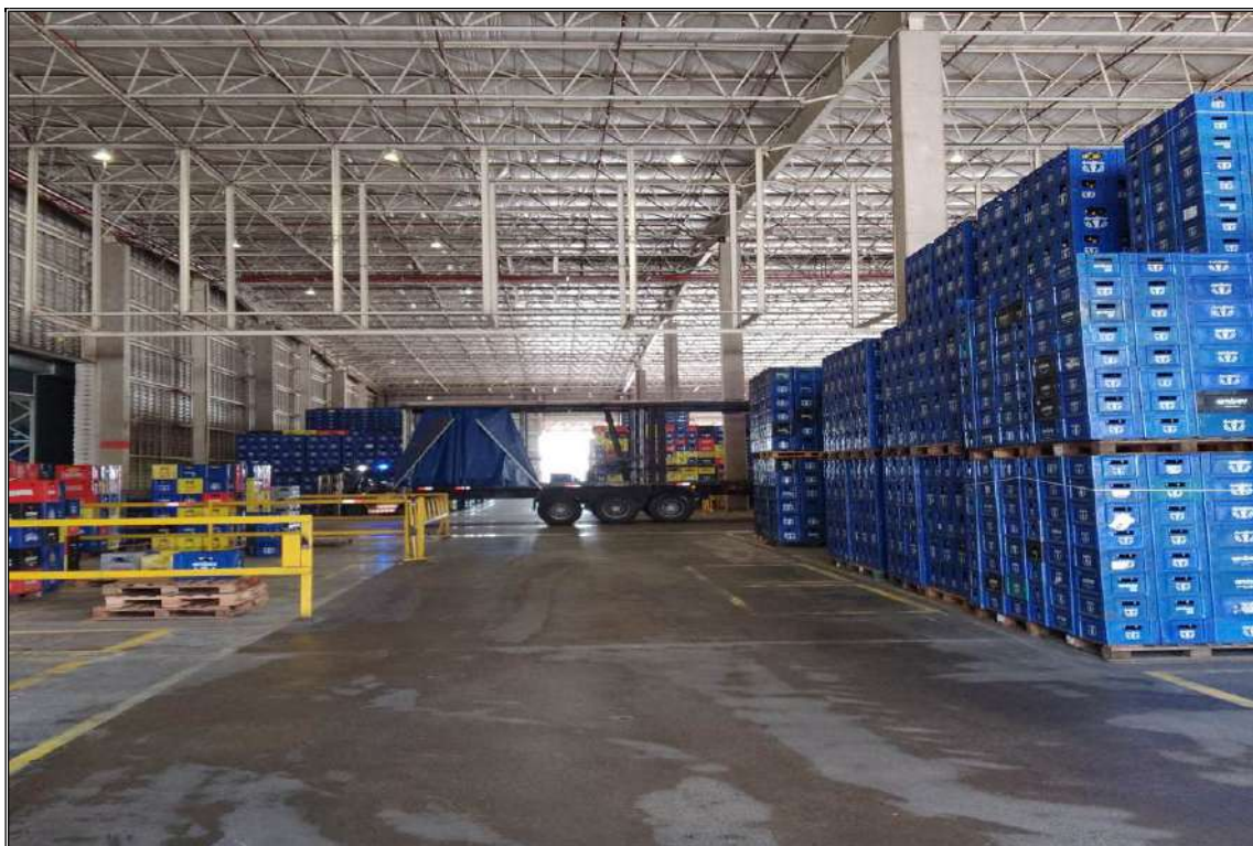
ARMAZÉM – VISTA INTERNA
