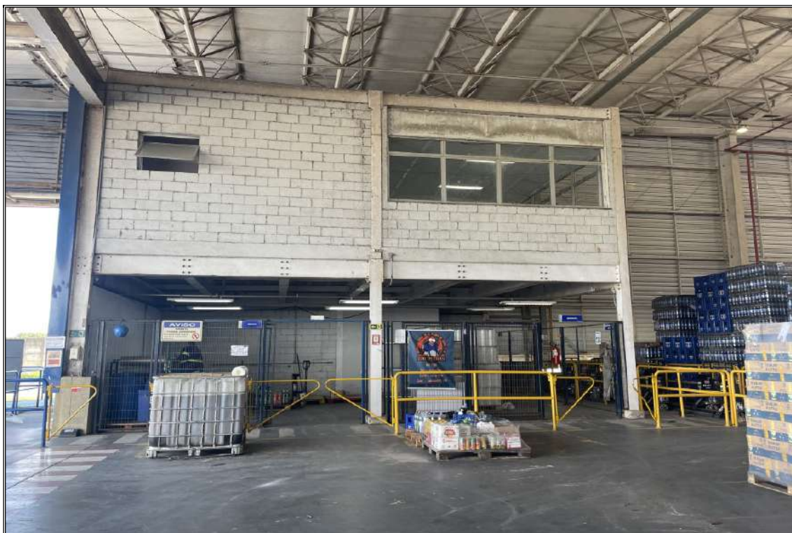
VISTA SALA DE CONTROLE
