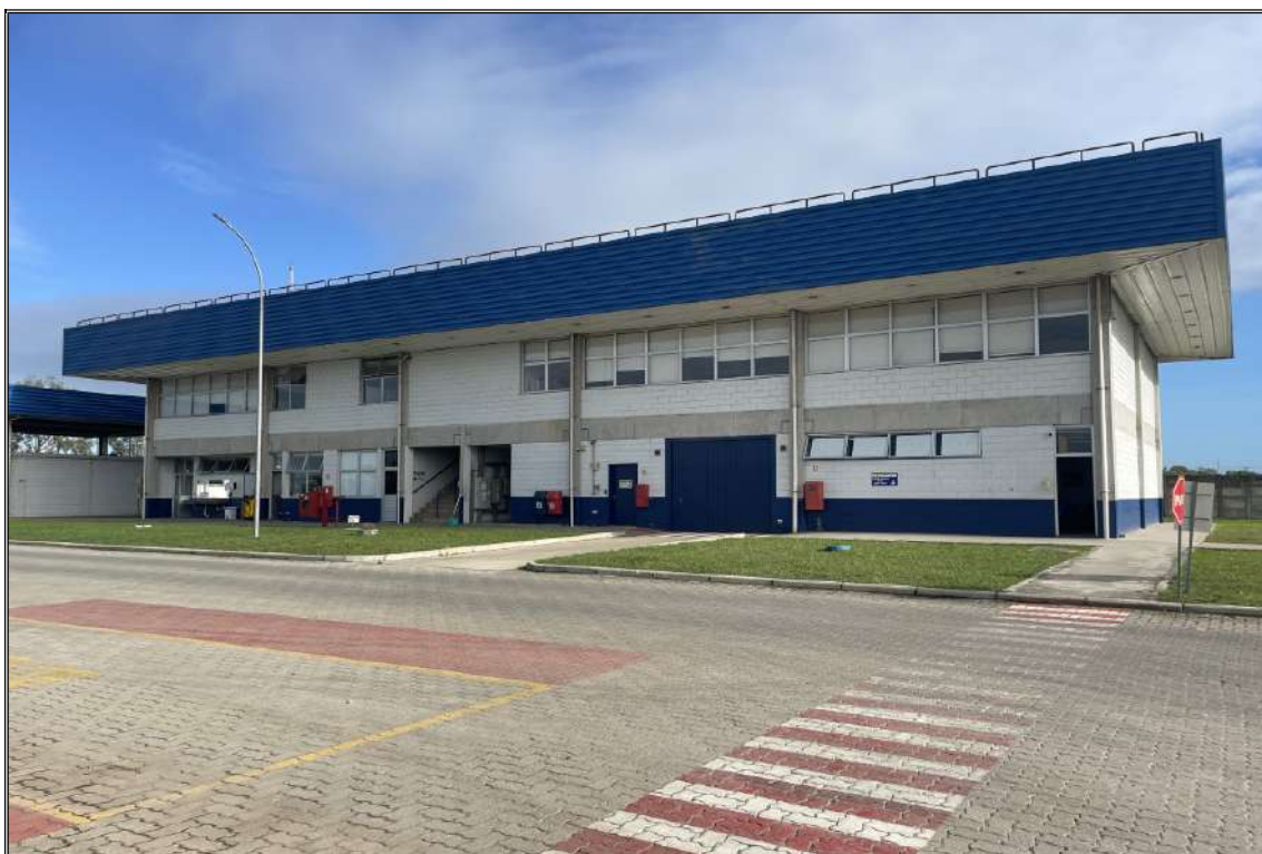
VISTA PRÉDIO ADMINISTRAÇÃO
