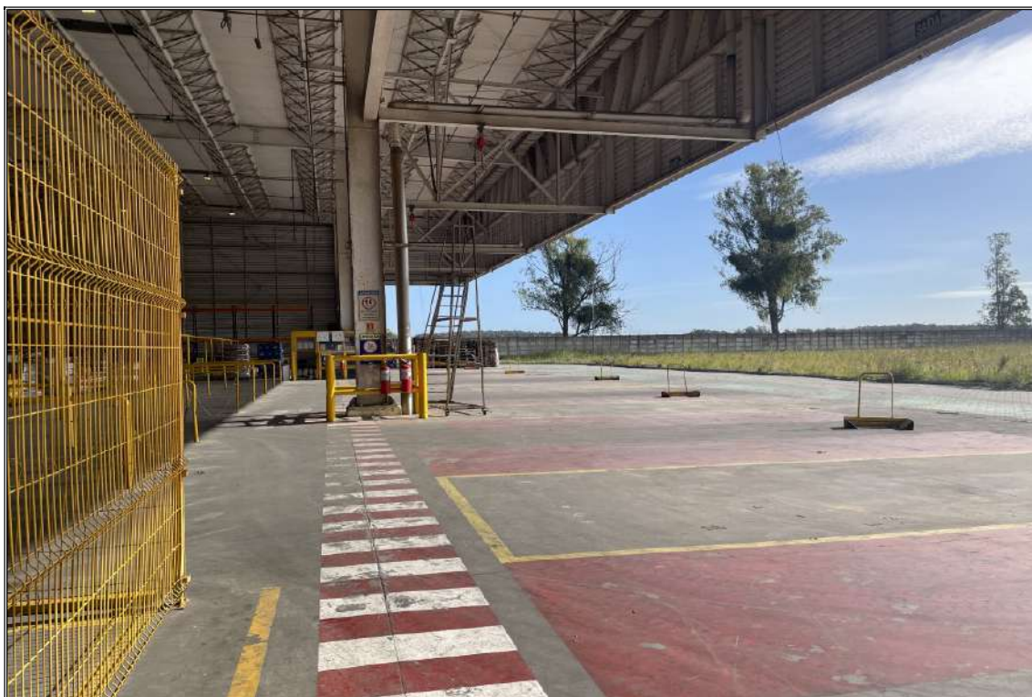
ÁREA DE CARREGAMENTO
