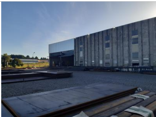
Vista Externa do Galpão
