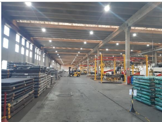
Interior do Galpão
