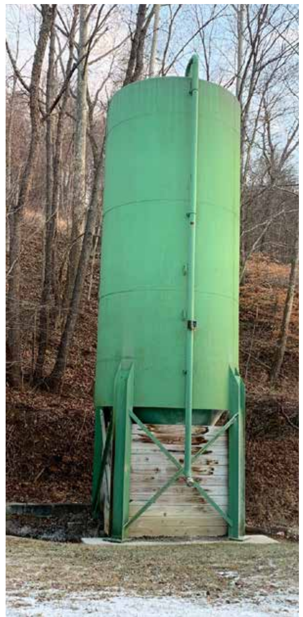
Lime Dosing Silo
