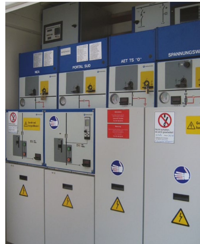
Tunnel Gotthard (Suisse)
