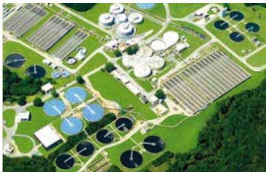
Управление на води и пречиствателни станции
