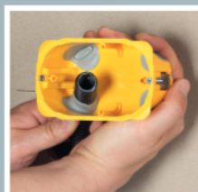
Insert the conduits
