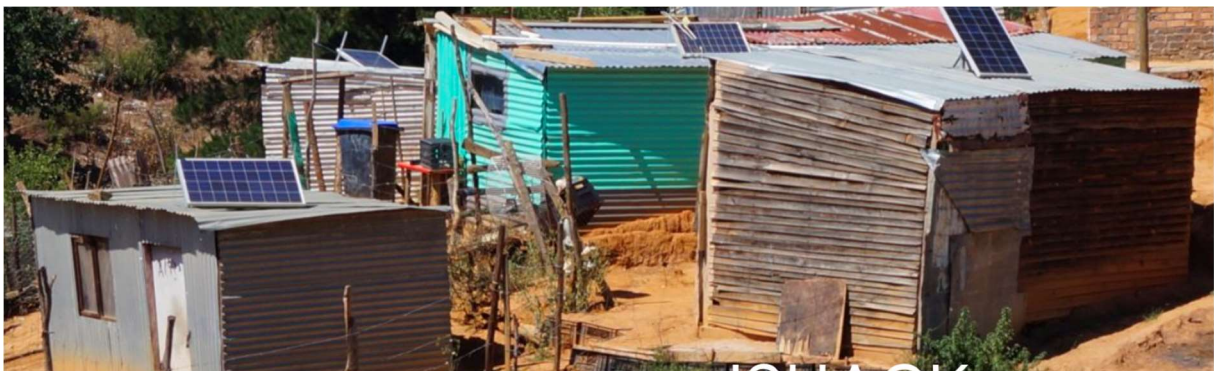
Figure 3.22. Infrastructure de panneaux solaires dans le quartier informel d'Enkanini, Afrique du Sud (source : institut de durabilité
