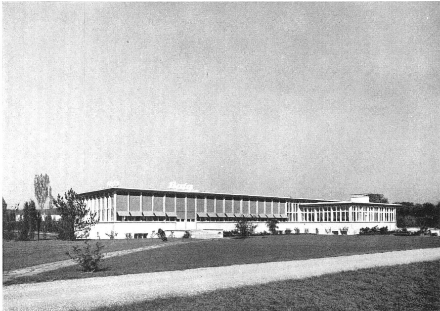
Clubhaus, Ansicht von Süden. Großer Saal mit Ausgang, rechts Konferenzzimmer und kleiner Saal | Le club. Façade sud. Grande salle et entrée, à droite la salle des conférences et la petite salle | Club house, view from South. Large club room with exit. At right conference room and smaller club room
