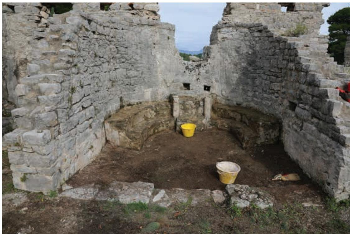
*Proces uklanjanja organskih materijala koji potiču obrastanje i propadanje trukture, provoden je mehanički i kemijski uporabom herbicida i aseptičnih sredstava*
