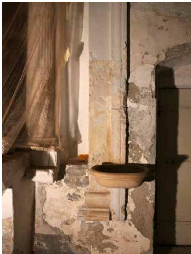
*detalj oštećenja; isoljavanje na južnom zidu razara površinu žbuke i kamena*
