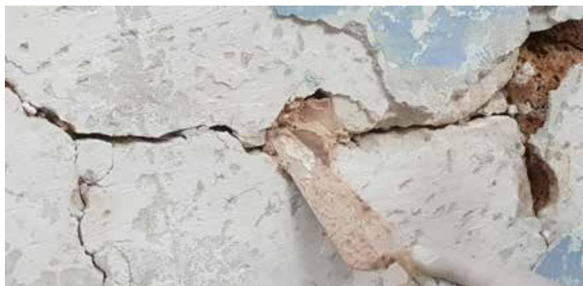
*radovi na konsolidaciji žbukanog sloja, injektiranje podbuhlina, fiksiranje pukotina*
