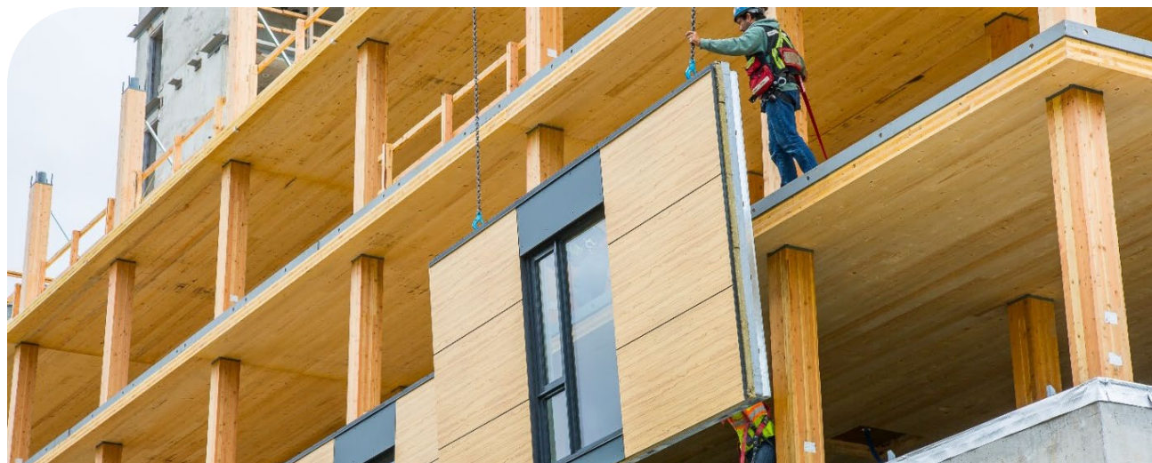
Brock Commons en cours de construction. KK Law, avec l'aimable autorisation de naturallywood.com
