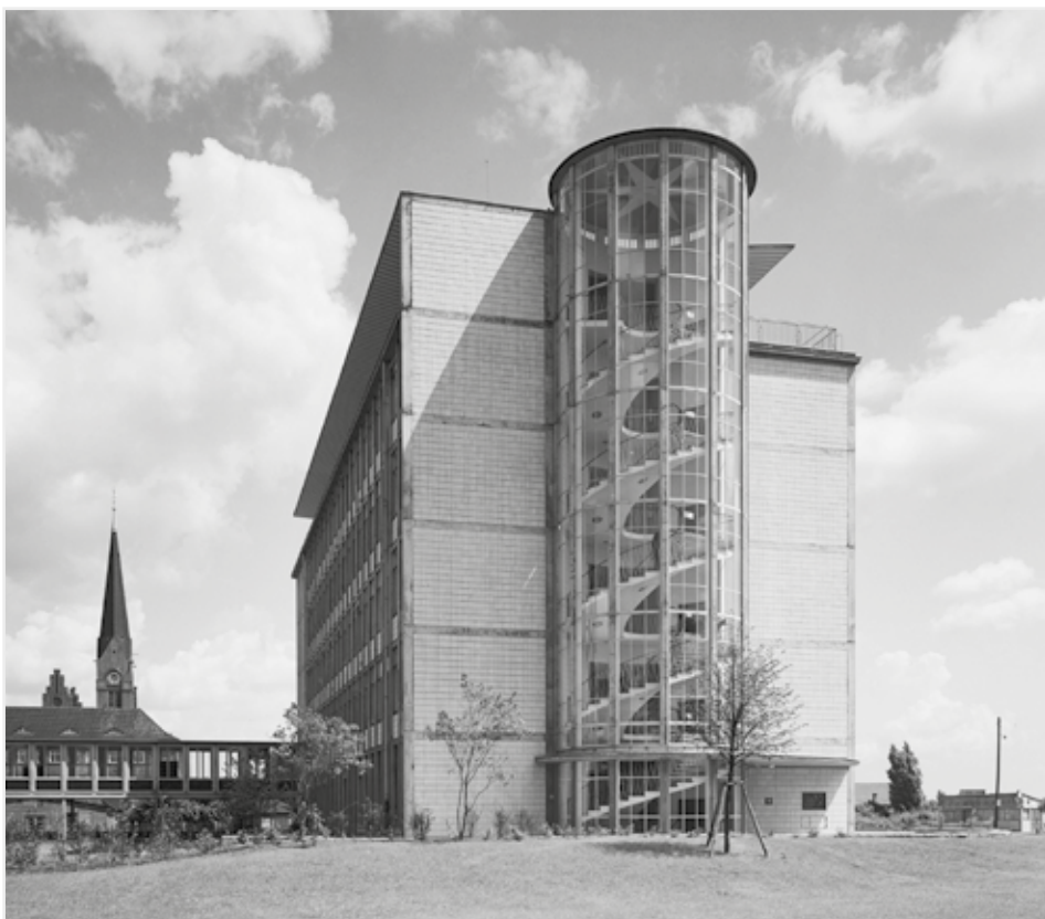
Abb. 8: Verglaster Treppenturm im BBZ Bremen (Foto: Hinrich Meyer. Mit freundlicher Genehmigung des Landesinstituts für Schule, Zentrum für Medien – Fotoarchiv)
