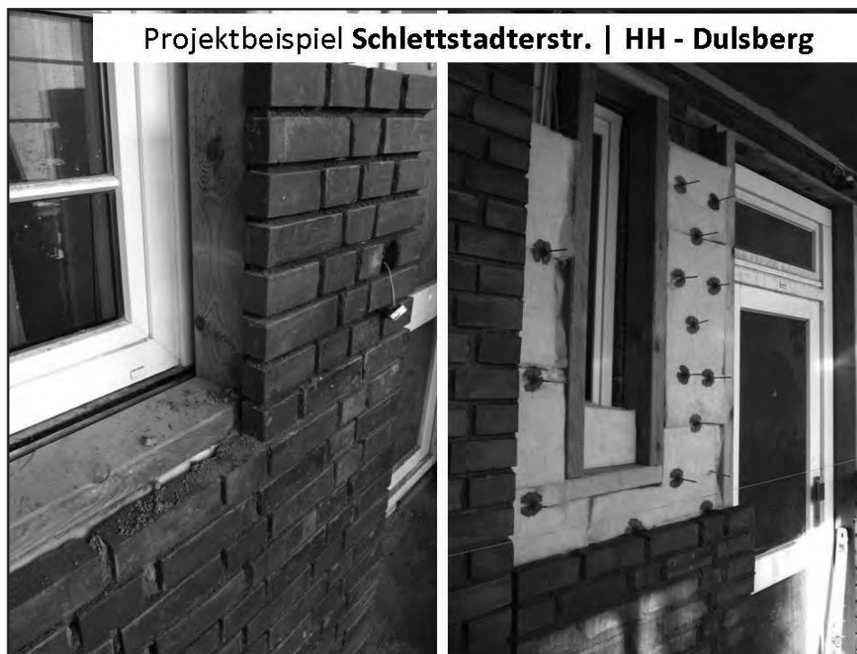
Abb. 6: „Neue“ Fassade mit Dämmschicht und Vormauerschale
