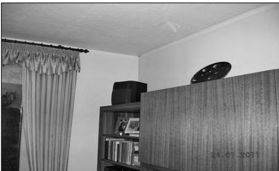
Abb. 6: Zimmerecke mit Innendämmung (Quelle: INFRARO)
