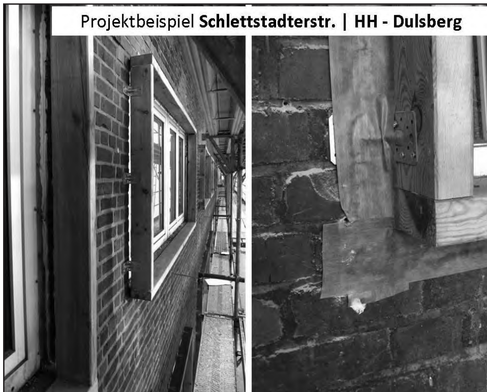
Abb. 5: Fassade im Bestand mit Holzrahmenkonsolen, luftdicht abgeklebt
