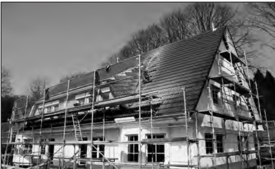
Abb. 1: Gebäudesanierung, Quelle: Energieagentur NRW
