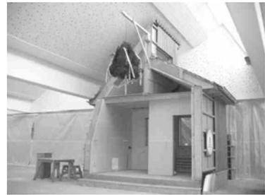
**Abb. 1: Das Hauptmodell Holzrahmenbau im Niedrigenergiestandard im ZzB**
