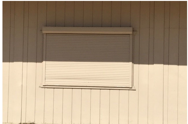
#40 D40 FIRE SHUTTER DOOR
