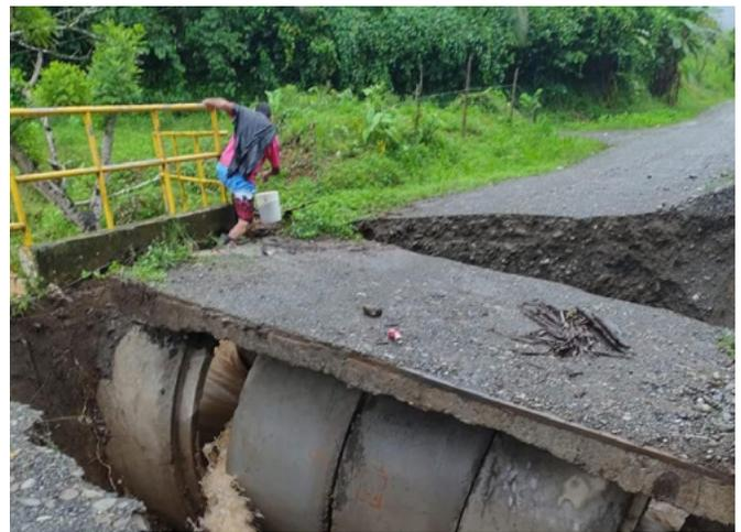
Ilustración 4: Calle dañada y alcantarilla desacomodada. Fuente: Municipalidad de Talamanca.
