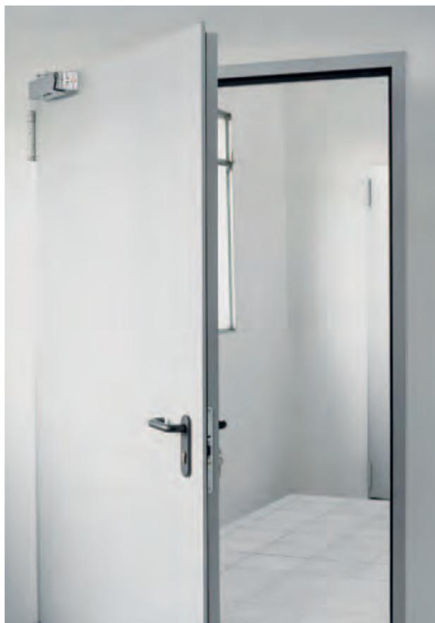
**I dispositivi del sistema sono stati testati durante la prova della messa in sovrappressione del locale filtro-fumo. Sono stati eseguiti test di apertura delle porte per simulare un esodo di persone, e verificata la chiusura delle porte alla fine del passaggio delle persone stesse.**
