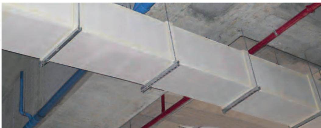
Global Building propone un sistema modulare per la costruzione di condotte di areazione EI 120 certificate con marcatura CE secondo norma EN 12101-7.
