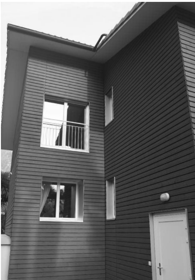
Die Nordseite des Gebäudes nun neu „eingepackt“
