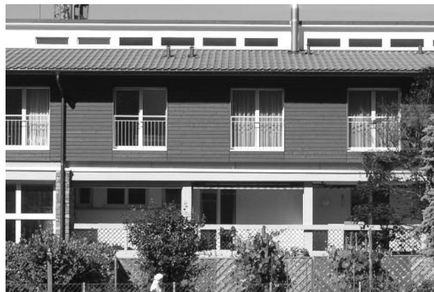
Vor den Isolationsarbeiten
