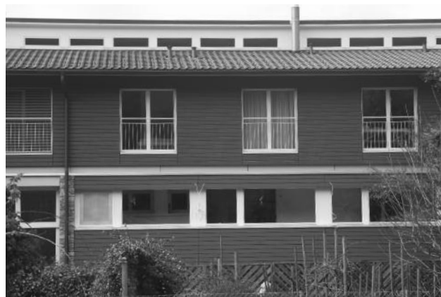
Nach den Isolationsarbeiten
