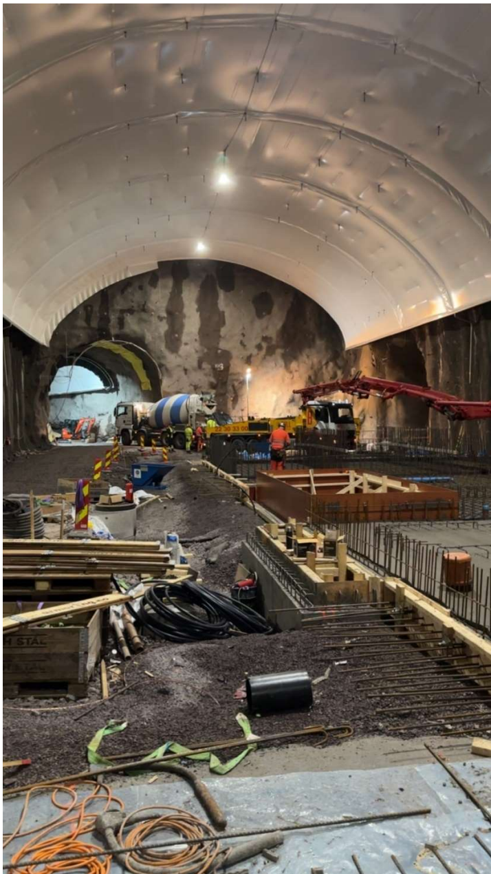
Grunn- og betongarbeider er godt i gang i en av fjellhallene.
