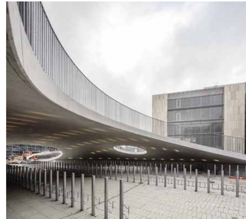
Overdækket cykelparkering. Karen Blixens Plads - Københavns universitet Amager.
