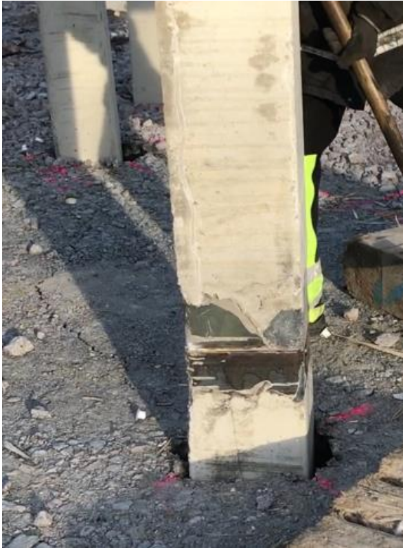
Bild 7. Pålelementer kopplas ihop.
