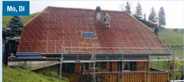
Gerüst, Ausdecken, Dunstrohre versetzen
