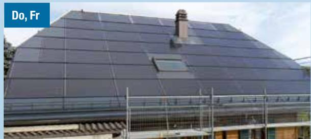
Montage der Solarstrom Laminare, Verkabelung, Spenglerei und Inbetriebnahme
