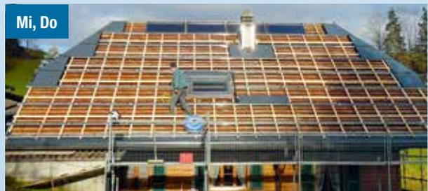
Montage der Unterkonstruktion, Schneefang, Blindmodule und Solarwärme Kollektoren
