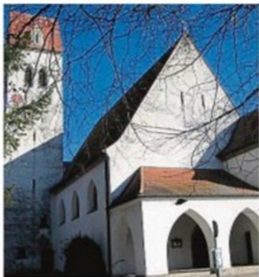
Die evangelische Erlöserkirche soll renoviert werden.
