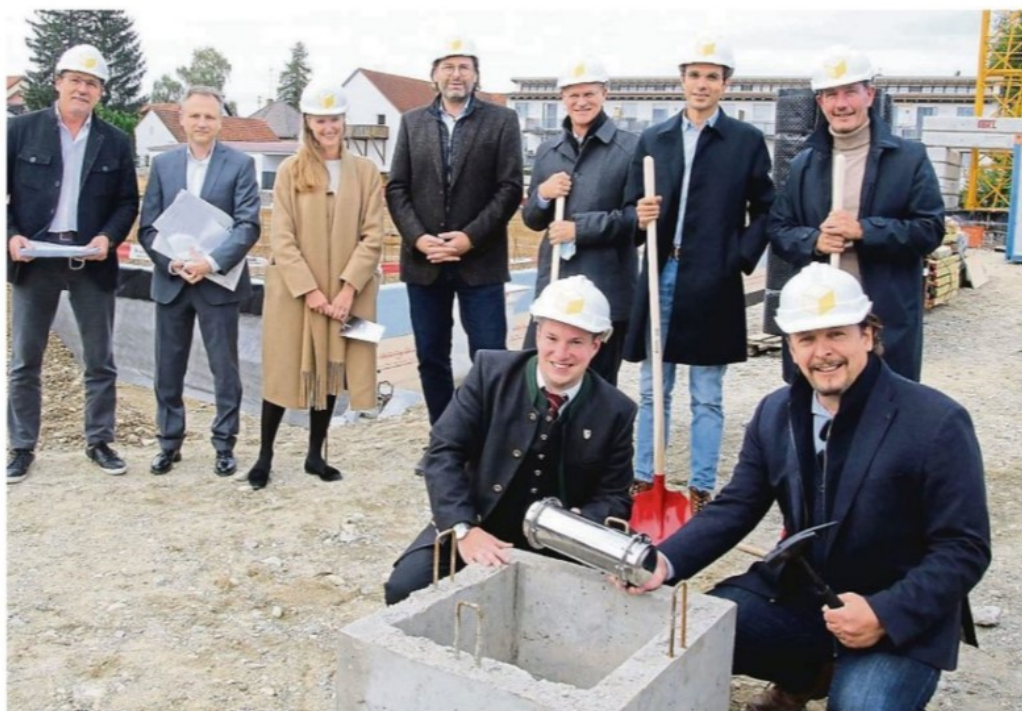
Bei der Grundsteinlegung für die Senioreneinrichtung platzierten (vorne v.l.) Bürgermeister Josef Heckl und Domizilium-Geschäftsführer Robert Auer Erinnerungsstücke an diesen Tag im Fundament. Betrieben wird das Haus die Diakonie (hinten 2.v.r. Alexander Härtlein vom Diakonischen Werk Fürstenfeldbruck).
