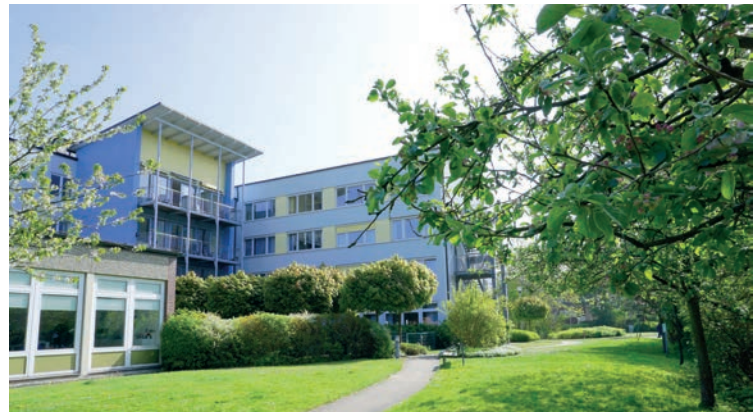
Ein Blick auf die Hausrückseite des Pflegewohnheims der DRK-Anschar-Schwesternschaft Kiel e.V., aufgenommen im letzten Frühjahr.
