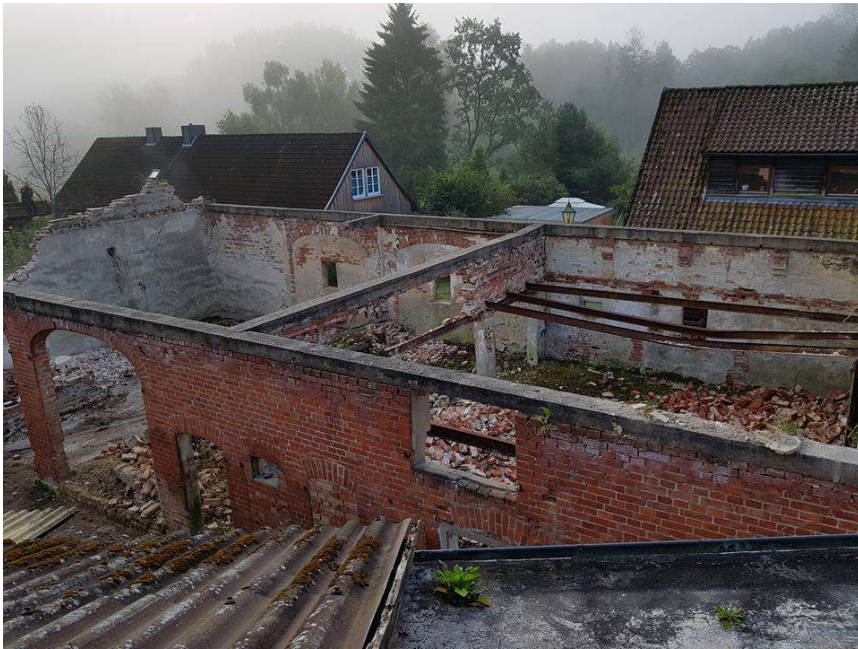
Abrissarbeiten am Vereinslokal
