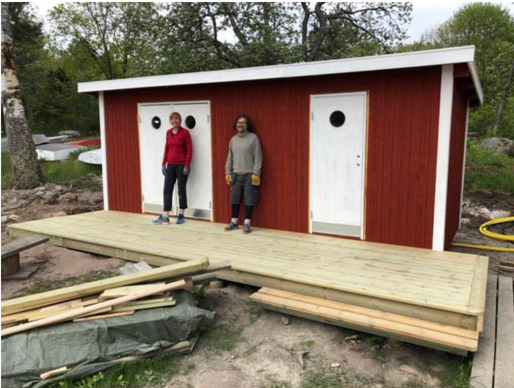
Målningsarbete, fönster monterades och altandäck byggdes.
