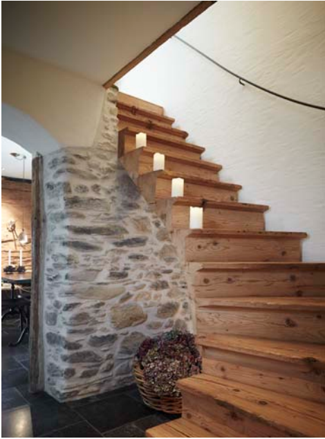
Handwerk: Die rustikale Treppe wurde aus zwei zweihundertjährigen Balken gezimmert.
