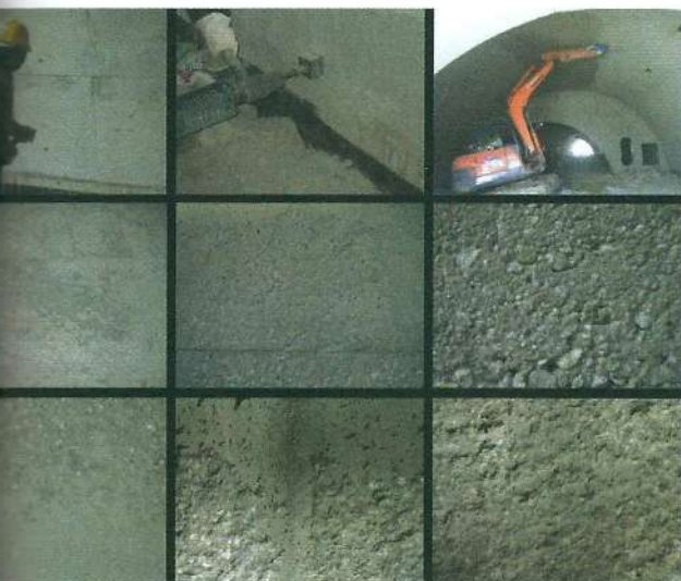
acabamento do betão armado
